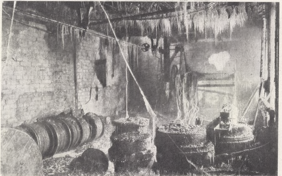
ELDSVÅDA I LILJEHOLMENS KABELFABRIK. H. 8. D:s Stockholmsfotograf. — Text å sid. 228.
