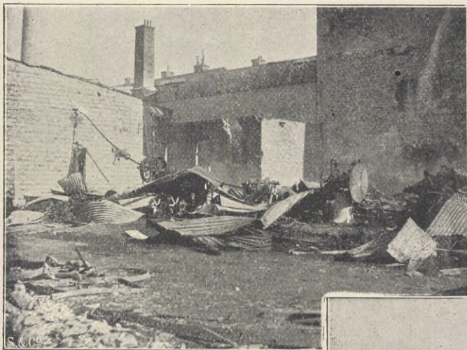
Tunnfabriken. Man ser axelledningen hänga från väggen, krökt som en ståltråd.
