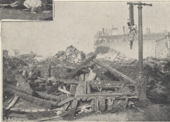
I fonden det brunna stenhuset, vid sidan af de räddade trähusen (s. k. landshöfdingehus).
