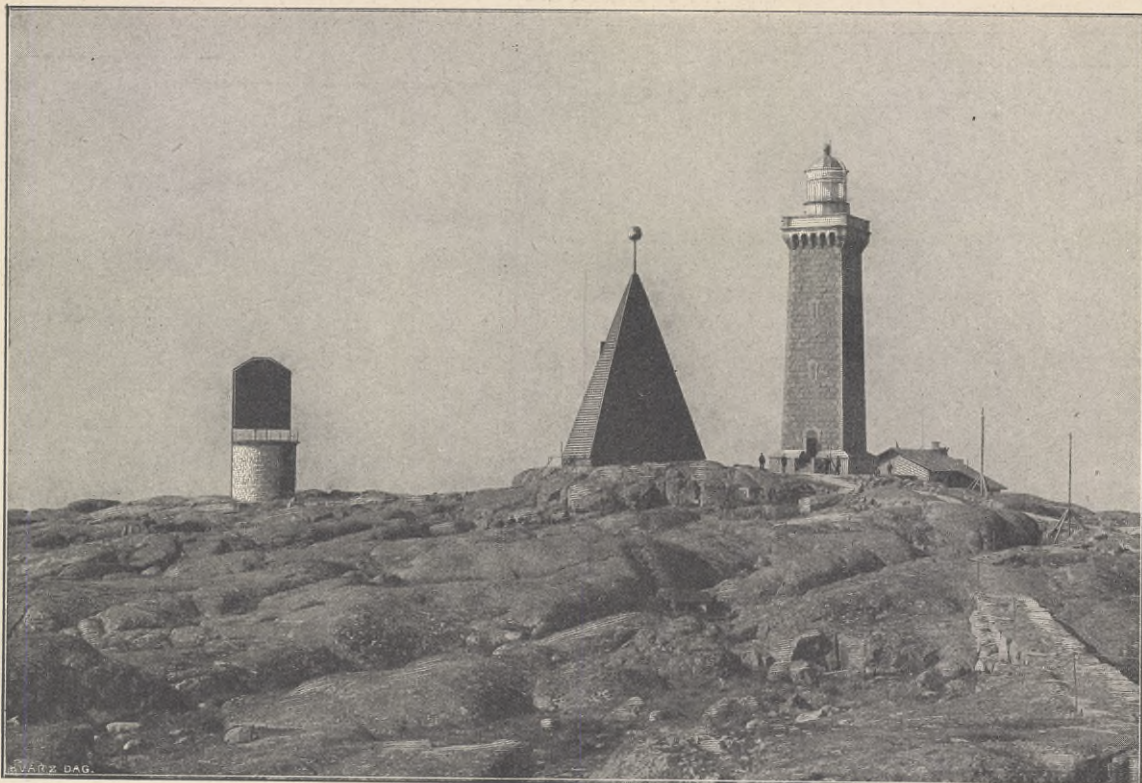
Foto. Hartman, Gbg. VINGA: Blänkfyrén, Båken med ishindertaflan (icke synlig å fotografien) samt den gamla Blänkfyrén (långst till vänster) med dess nu mera icke använda issignaltafla. Kliché: Bengt Silfverparre.
