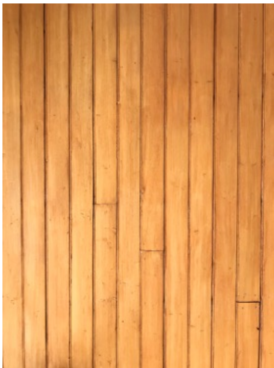
Fig 28. Detaljbild pärlspontspanel i tak.
