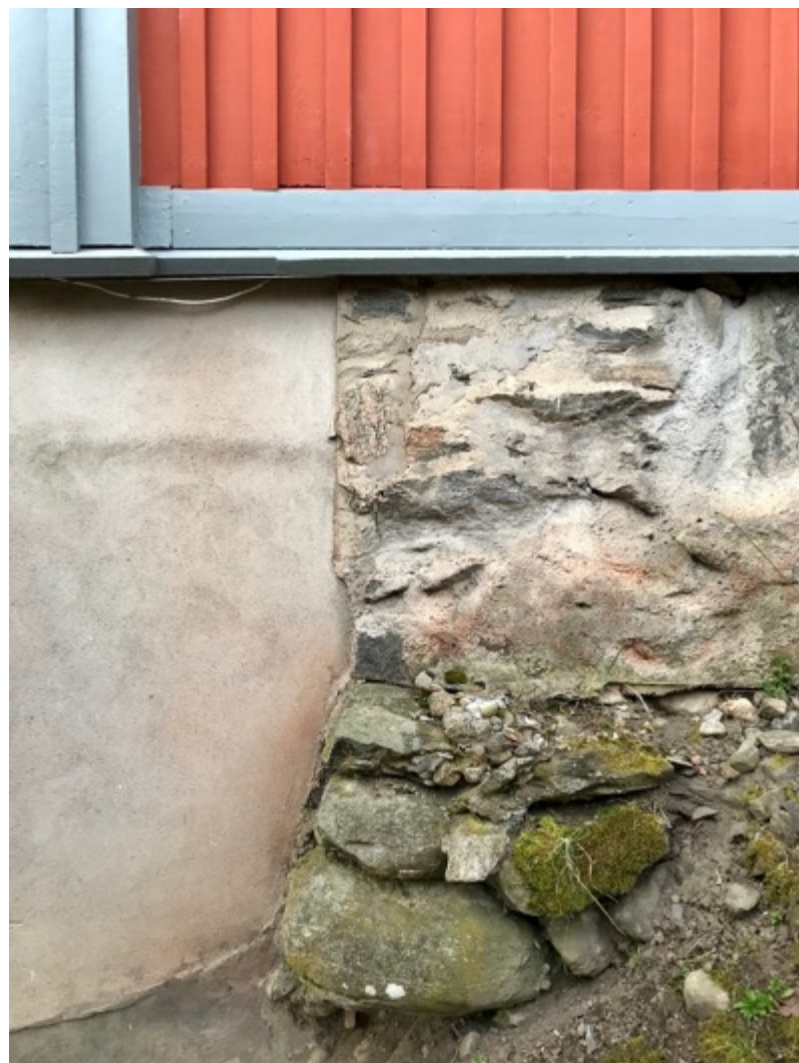
Fig 25. Del av Källnäas murade naturstenssockel. Till vänster i bild senare slätputsad del av källarplanets mur.
