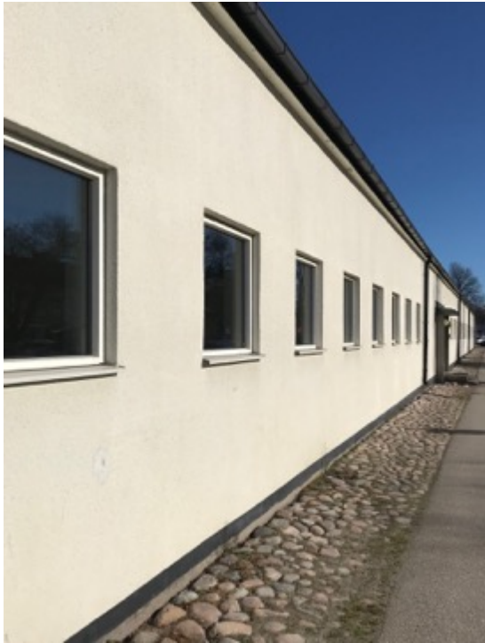
Fig 84. Putsad fasad på den låga delen av byggnadens östra långsida.
