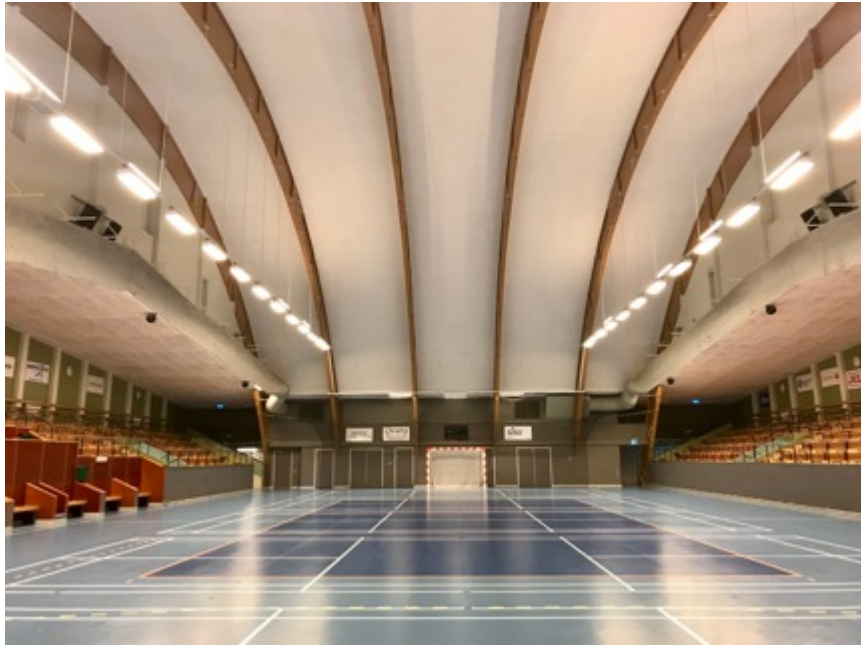
Fig 69-72 Interiörbilder Odenhallen i Falköping. Nya ytskikt samsas med bevarade originaldetaljer. Karosseripanel och trappträcken (bilder nedre raden) är exempel på ursprungliga detaljer som finns kvar. Läktarna har nytillverkade bänkar i ett utförande likt det ursprungliga. I samband med den senaste renoveringen (2008) utrustades hallen bland annat med ett nytt ventilationssystem och golv. Den varierade färgsättningen i foajén återkommer i sporthallen. På bilden längst upp till vänster syns de numera igensatta fönsterpartierna i gavelröstena.
