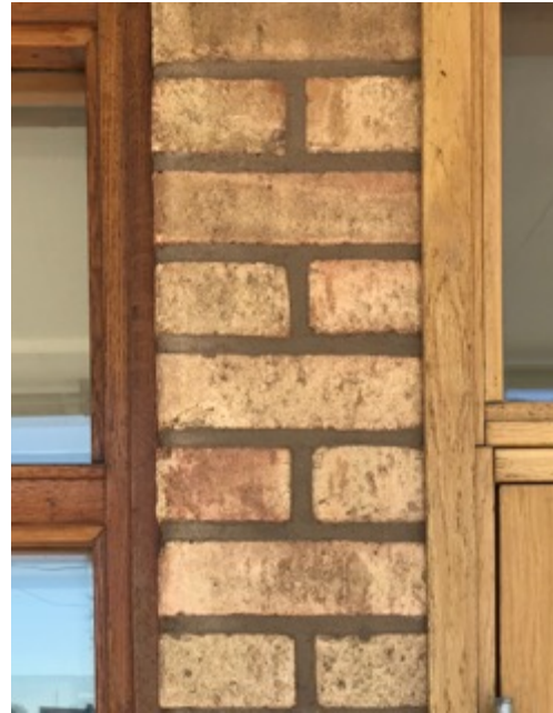
Fig 59-63 Exteriörbilder Odenballen i Falköping. På bilderna syns de olika fasadmaterialet. Huvudentréns gula tegel möter dörrar och fönsterkarmar i ek med fönsterbleck i kopparplåt. Övriga fasader är putsade i olika kulörer. Längst ner till höger syns ett av de numer plåtbeklädda gavelröstena i idrottsballens takkonstruktion. Notera även nyare tillägg i brottarlokalen längs den östra långsidan och huvudentréns nya tillgänglighetsanpassade ramp.
