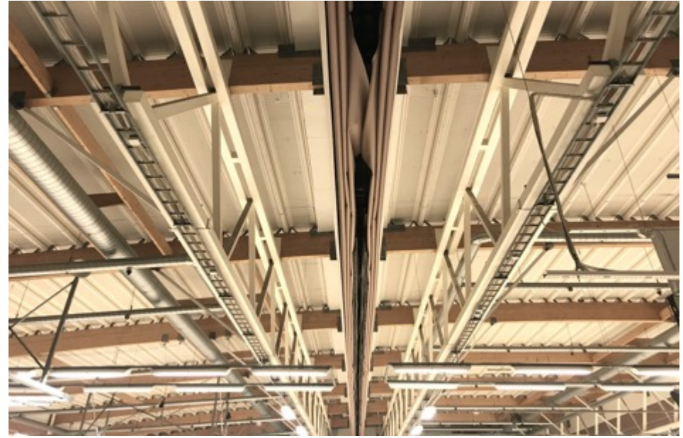
Fig 119-121. Interiörbilder Agnebergshallen. Till vänster syns den vågformade väggen längs den västra läktargången. Hallens takstolskonstruktion utgörs av både fackverkstakstolar i stål och tvärgående limträbalkar. Centrerat i bilden ovan syns även en av hallens nedfällbara riktväggar. Bland hallens fasta inredning finns bland annat ribbstolar och basketkorgar.
