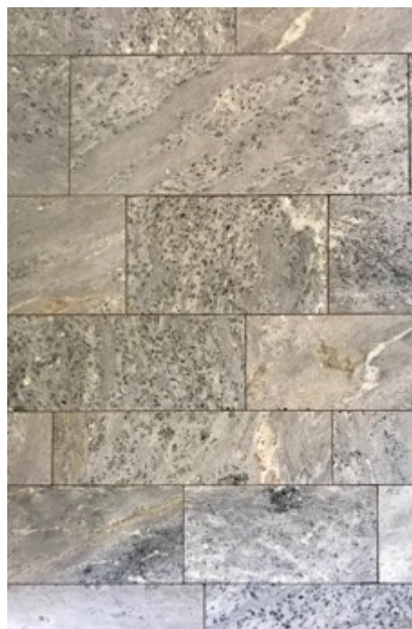
Fig 67. Kalkstensgolv i foajé.
