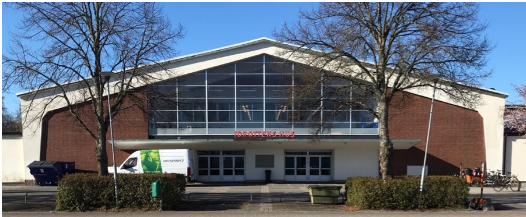
Fig 80. Huvudentrén till Idrottens hus. De mest påtagliga elementen i gavelns estetiska utformning är ramkonstruktionen i betong och det stora glasade partiet.
