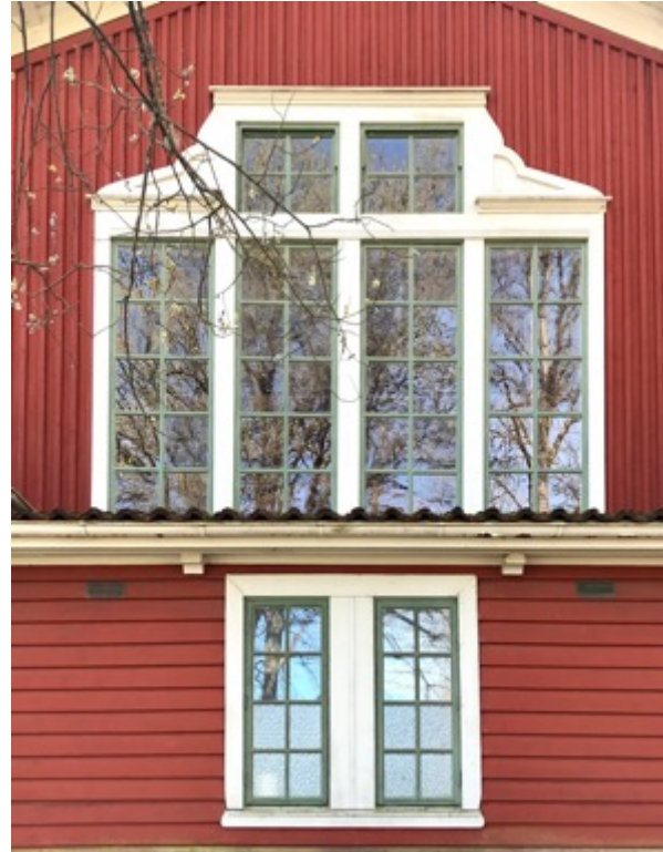
Fig 8. Glasat parti på Lekhusets norra gavel. Fönstret nederst i bild släpper in ljus till biutrymmen. Notera den liggande panel på byggnadens låga delar.
