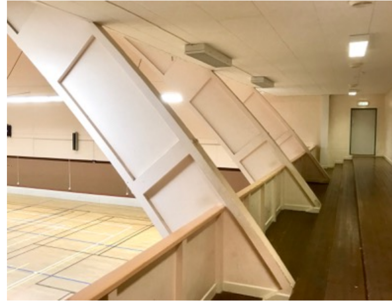
Fig 42. Limträkonstruktionen och ståplatsläktare vid den norra kortsidan.
