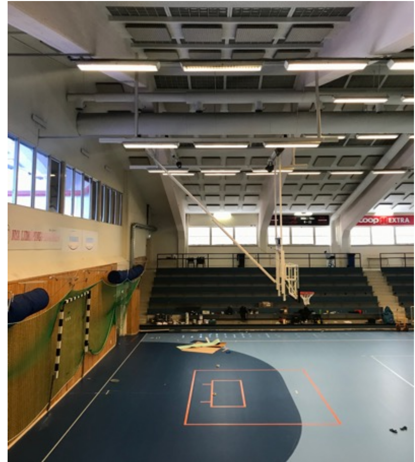
Fig 97-100. Interiörbilder Idrottens hus. På bilderna syns takstolarnas ramkonstruktion och spännvidd. Till vänster syns ljusinsläppet från den norra kortsidans fönsterparti genom budoballen. Notera att den västra långsidans fönsterband utmed läktargången satts igen. Hallens färgsättning går i kulörerna grå, ljus rosa och blå. På bilden nere till höger skimras partier av glasbetong som tidigare gav ljusinsläpp genom taket.
