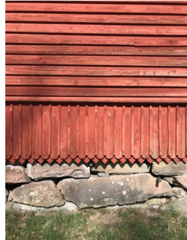
Fig 9. Lekhusets grund utgörs av både cement- och kallmurad natursten. Här syns även den dekorativa panelbeklädnaden som återfinns på båda kortsidor.
