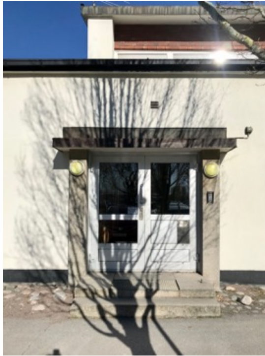
Fig 85. Entréparti med aluminiumdörrar på östra långsidan.
