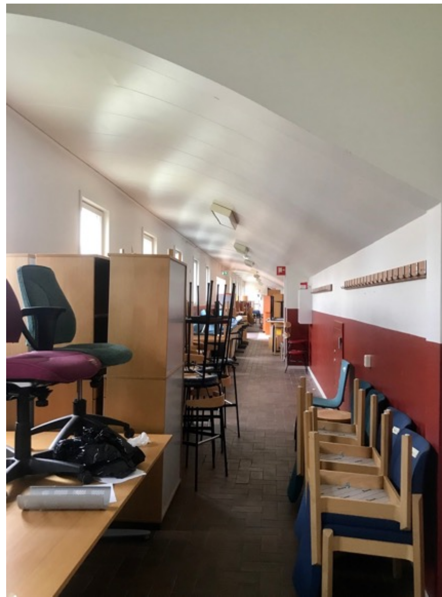
Fig 49. Entréhallen utmed östra långsidan. Sluttande tak under läktare.
