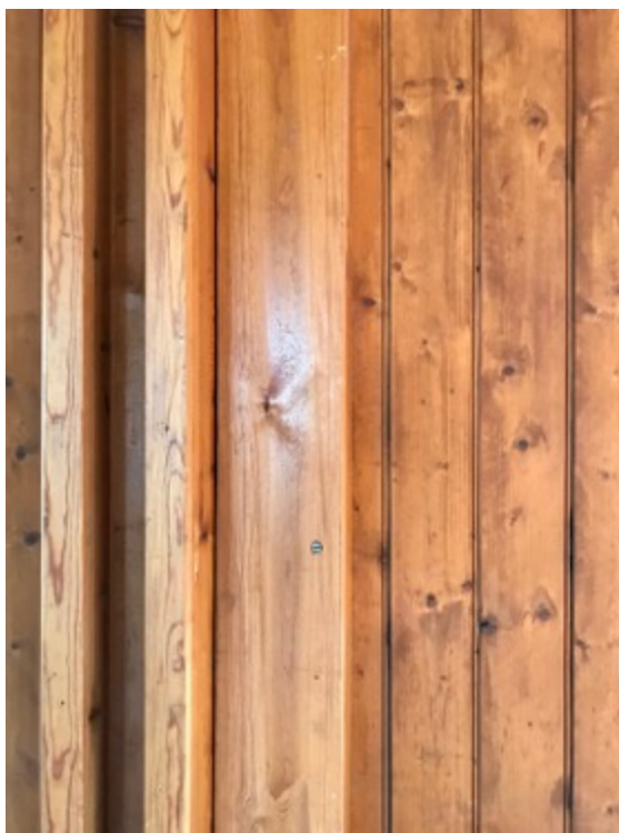
Fig 29. Detaljbild vägg med infästning för bommar.
