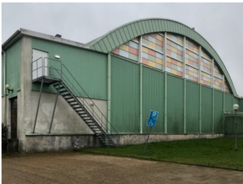
Fig 36-40. Exteriörbilder Uddevalla Idrottsball. På bilderna syns bland annat de fasadmateriäl i trapetskorrugerad plåt och puts som återfinns utmed byggnadens alla sidor. Längst ner till vänster syns ett av de igensatta glaspartierna i idrottsballens gavelrösten. Byggnadens exteriör har genomgått stora förändringar men spår av den ursprungliga utformningen finns kvar i formspråk och detaljer, exempelvis i entrépartiet och de ursprungliga pardörrarna med överljus utmed den norra kortsidan (längst upp till böger).
