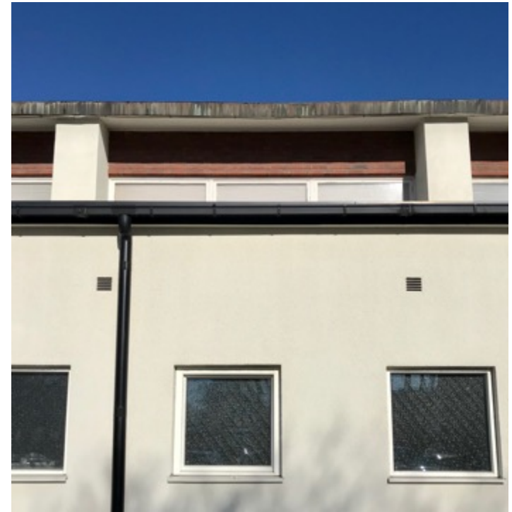
Fig 86. Fönsterband under takfot med ljusinsläpp mot sporthall.
