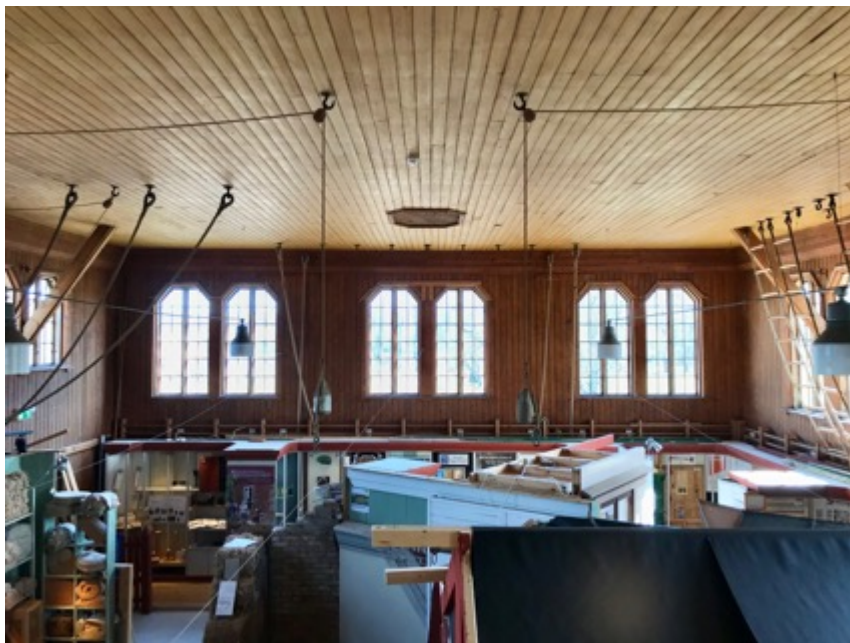
Fig 26. Källnäas interiör våren 2020 med nuvarande utställning. Ursprungliga gymnastikredskap med tillhörande infästningar i väggar och tak finns bevarade bakom utställningens väggar.
