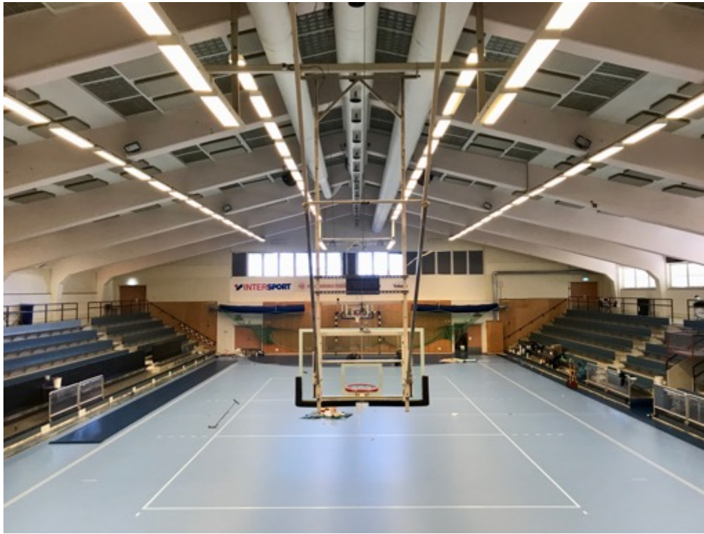
Fig 97-100. Interiörbilder Idrottens hus. På bilderna syns takstolarnas ramkonstruktion och spännvidd. Till vänster syns ljusinsläppet från den norra kortsidans fönsterparti genom budoballen. Notera att den västra långsidans fönsterband utmed läktargången satts igen. Hallens färgsättning går i kulörerna grå, ljus rosa och blå. På bilden nere till höger skimras partier av glasbetong som tidigare gav ljusinsläpp genom taket.
