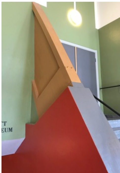
Fig 66. Limträkonstruktionens stödpunkt.
