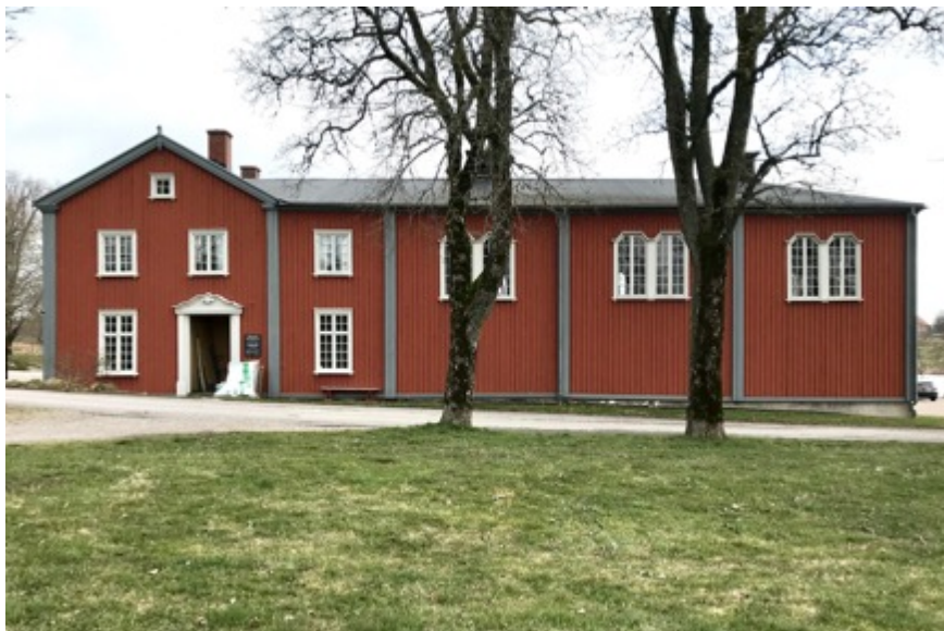
Fig 22. Källnääs södra långsida. Till höger i bild gymnastiksalen. Gavel till vänster tillhörandes den vinkelställda administrativa delen av byggnaden.
