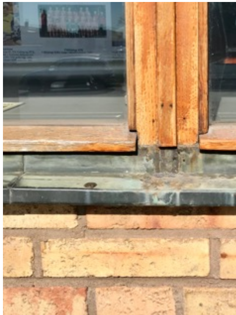
Fig 59-63 Exteriörbilder Odenballen i Falköping. På bilderna syns de olika fasadmaterialet. Huvudentréns gula tegel möter dörrar och fönsterkarmar i ek med fönsterbleck i kopparplåt. Övriga fasader är putsade i olika kulörer. Längst ner till höger syns ett av de numer plåtbeklädda gavelröstena i idrottsballens takkonstruktion. Notera även nyare tillägg i brottarlokalen längs den östra långsidan och huvudentréns nya tillgänglighetsanpassade ramp.
