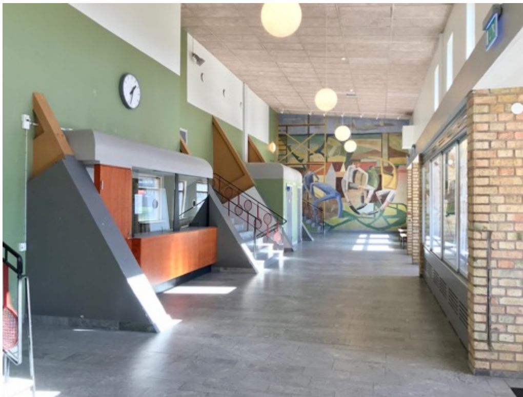
Fig 64. Odenhallens foajé med kalkstensgolv och muralmålningar. Notera limträkonstruktionen som skär genom innerväggen mot sporthallen.
