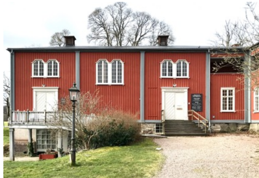
Fig 23. Källnääs norra långsida med entréer direkt in till gymnastiksalen.
