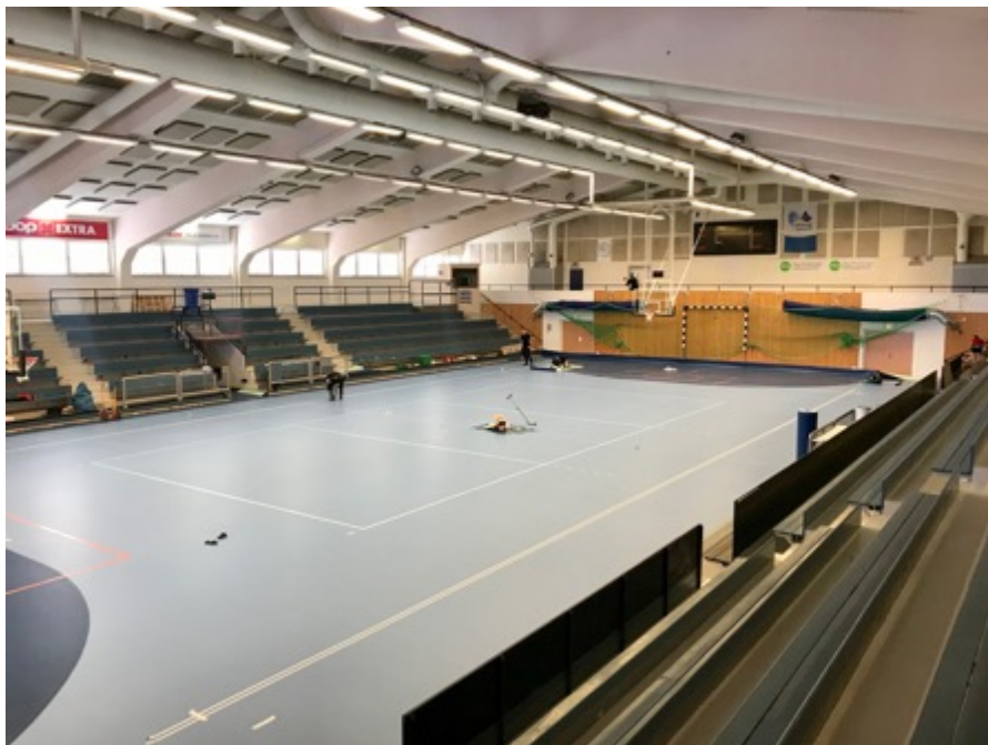
Fig 92. Sporthallen i idrottens hus. På bilden syns pågående arbete med nytt sportgolv och ommålning av läktarnas bänkar.
