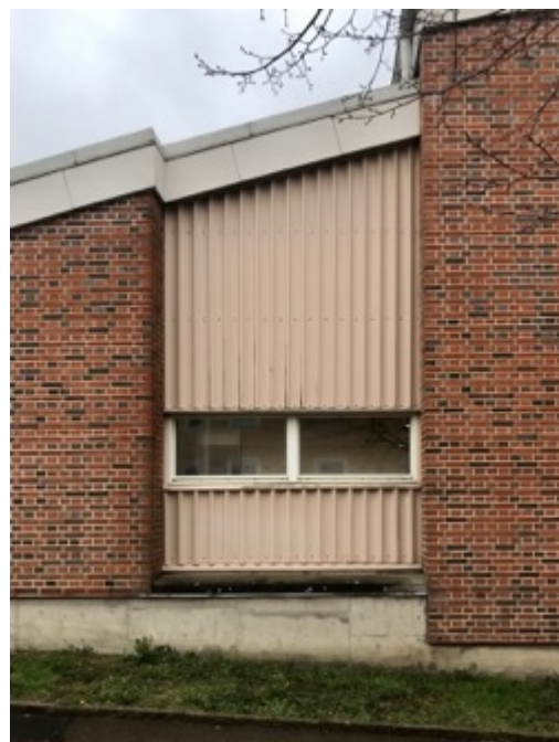
Fig 107-111. Exteriörbilder Agnebergshallen. På bilderna syns fasadmaterialet tegel och plåt som återfinns på samtliga fasader. Skylten 'Agnebergshallen' finns på entrésidan. Det välvda formspråket är återkommande och kan ses på de två nedersta bilderna samt i undertaket av arkaden (Bilden överst i mitten).
