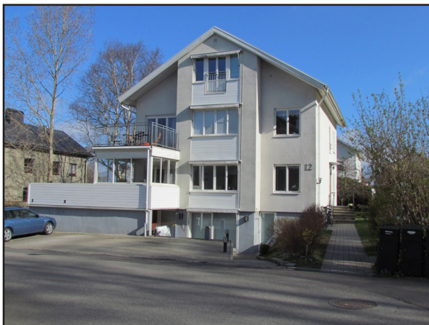
Figur 13: Fastighet i Sävenäs
