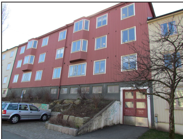
Figur 12: Fastighet i Kungsladugård
