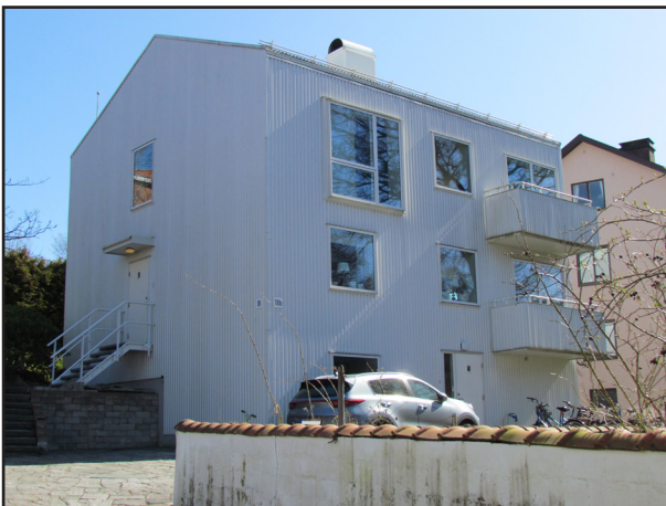
Figur 9: Fastighet i Kungsladugård
