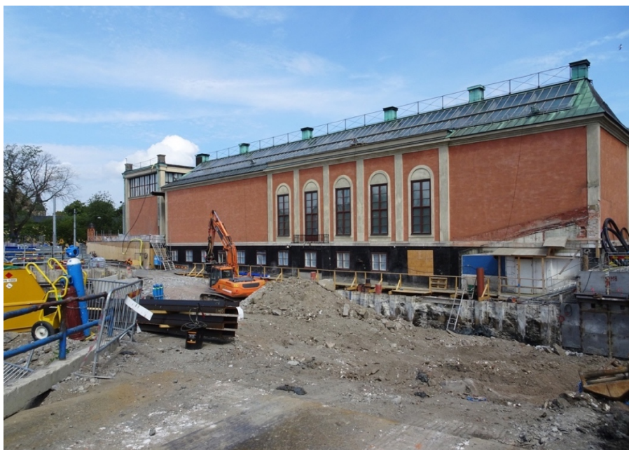
Fig. 22. Byggnadsarbetet är igång på platsen för tillbyggnaden, juli 2018. (Holger Ellgaard 2018)
