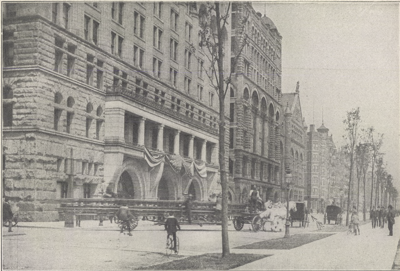
FRÅN CHICAGO: Michigan Avenue, intill hvilken Iroquois-teatern var belägen. Pilen pekar in mot en liten gatudel, vars inre ända förde till teaterns ingång. Den närmaste, stora byggnaden är en del af »Auditorium», en kolossal teater-, konsert- och restaurantbyggnad.
