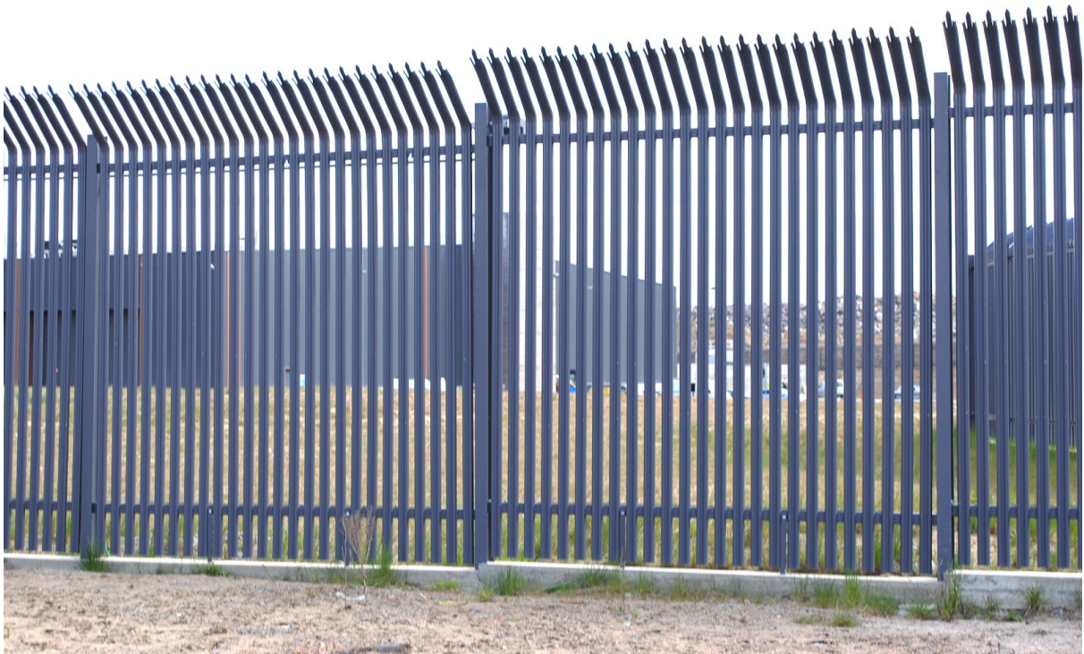
Figur 2: Företaget Amazon Web Services datahall som omgärdas av ett högt staket. (Barr, Norlin & Ringvall 2020)
