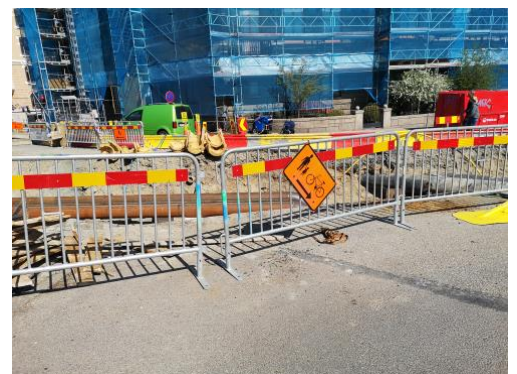
(Bild 1. Bilden visar en vanlig typ av staket runt en byggnation)
