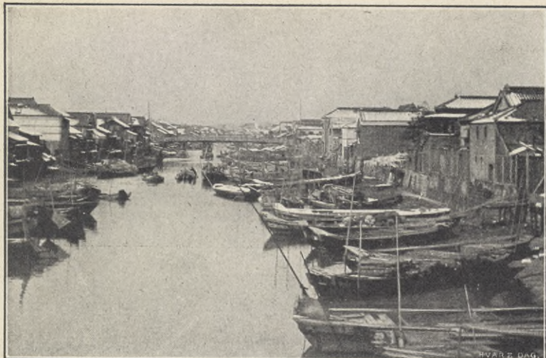
KANAL I TOKIO MED »SAMPANS».
