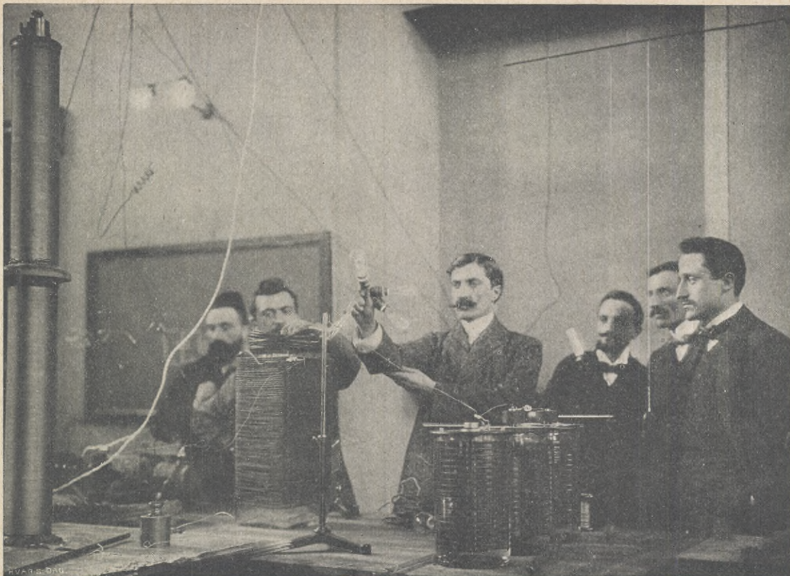
POULSENS BÅGE FÅR PÅ AFSTÅND GLÖDLAMPOR ATT LYSA.
