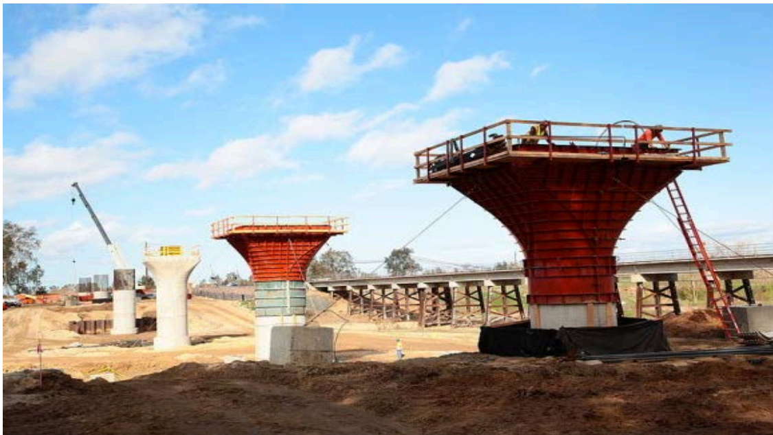
Figur 7.7 Pågående utbyggnad av järnvägen för höghastighetståg i Kalifornien.
