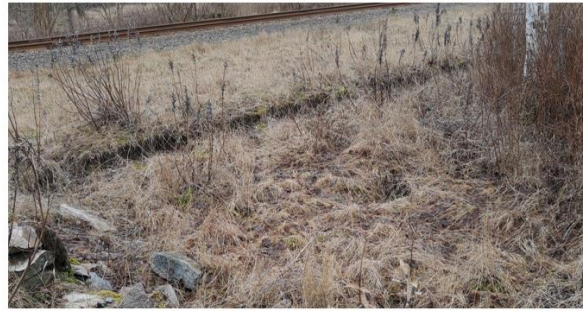
Figur 54: Österängs järnvägsparks lokstallsruin
