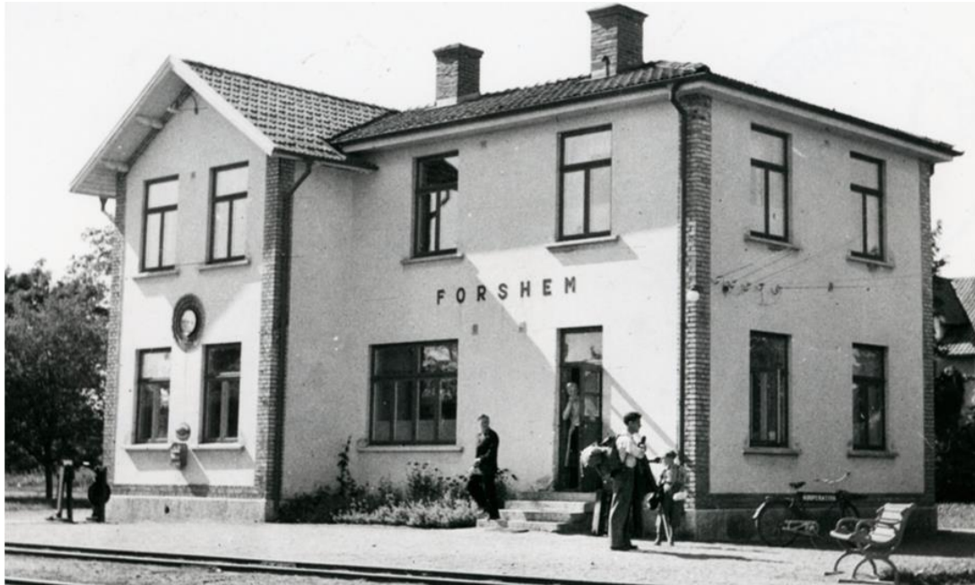
Figur 25: Forshems ombyggda stationshus år 1945 (Järnvägsmuseet, 2020)
