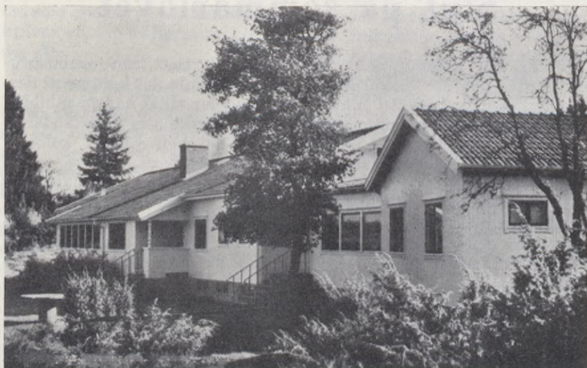
Här är en nytagen bild av Göteborgsföreningens sommarhem, Hällungen. Så flott har det blivit genom tillbyggnaden.
