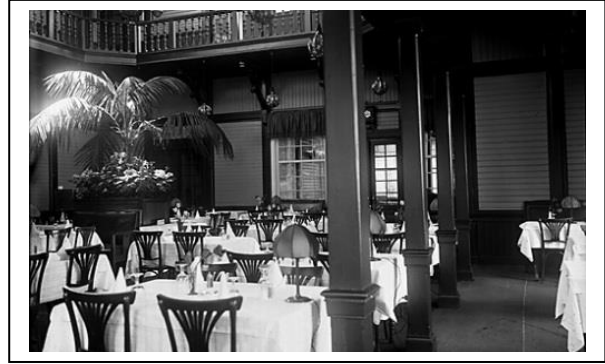
Figur 9. Restaurangens serveringslokal i början av 1900-talet. Karlstads historia (2009).
