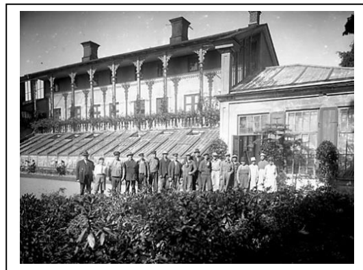
Figur 5. Orangeriets baksida med arbetslag (u.å.) Karlstads historia (2009).
