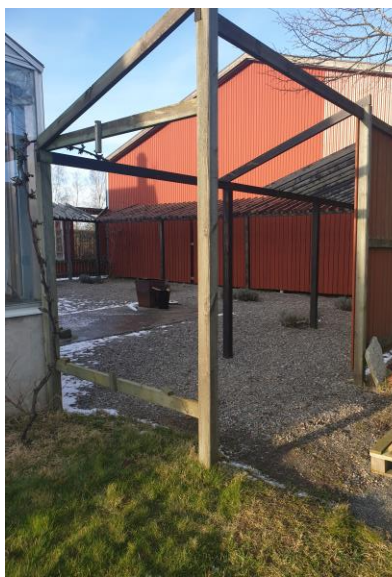
Figur 15. (Vinterbild) Står och fotar vid Solsidan in mot Innergården . Takbjälkarna är inte färdiga längs ut med hela pergolan. Planket skymtar höger om bilden. Rakt fram syns maskinhallen och växthuset syns vänster i bild.
