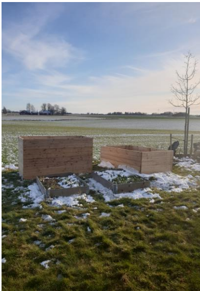
Figur 22. (Vinterbild) Nya drivbänkar är under konstruktion. De är gjorda av överblivet lärkträ, det skall bli tre stycken totalt i en bra arbetshöjd med fönster.
