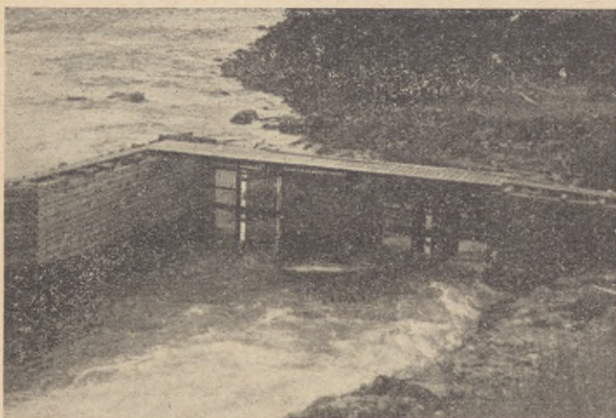
Laxfiske i Luleälven (Edefors. Genom de smala öppningarna i gallerverket hoppar laxen upp i den strida strömmen i dammen.)
