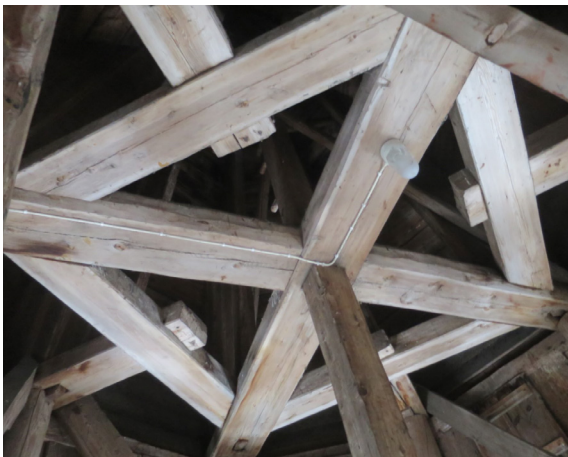
Bild 1: Tornets bindbjälkar sedda underifrån
