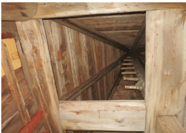
Bild 5: Bindbjälkar till lanterninhuvens samt den genomgående mittstolpen
