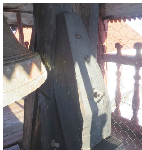
Bild 4: Klockplan. Grov snedsträva med genomgående bultar
