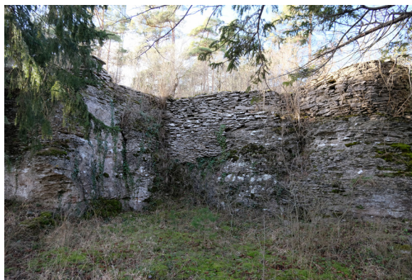
Figur 15: På bilden syns tydligt hur de förstärkt de resan existerande klipporna med hjälp av kalkstensmurning.
