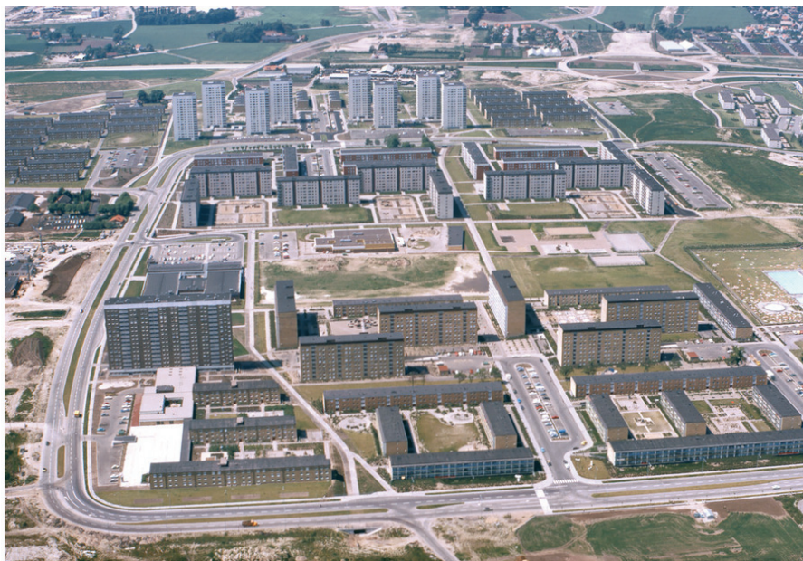
Bild 52. Lindängen från öster år 1973. Munkhättegratan ringar in bostadsområdet. Vid Munkhättegratans hitre del löper återvändsgatan Kantatgatan in i området, med delar av verket Pilallén på ömse sidor om mynningen. Snett ovanför återvändsgatans inre rundning syns Fia med knuff . Vid den öppna gården söder om men ej synliga på bild finns ”regnbåge” och ”lekrör”. © Malmö stadsarkiv.
