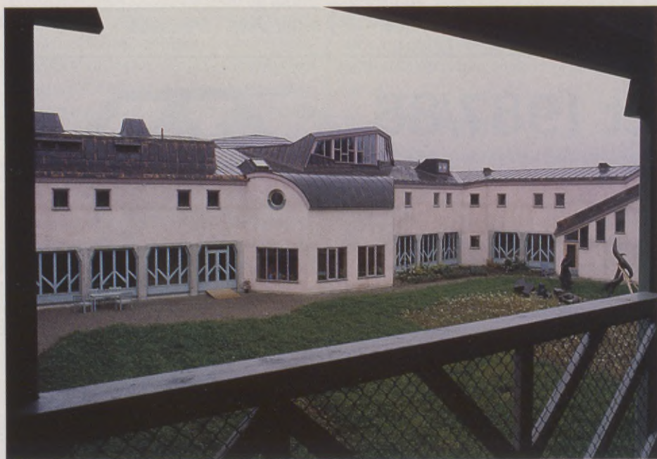
Vidarkliniken är ett annorlunda sjukhus, utvändigt och inuti. Det byggs ut i etapper efter resurser och varefter nya former för verksamheten växer fram. Färdigt ska här finnas 74 vårdplatser. Den inbyggda gården ska bli kryddträdgård.
