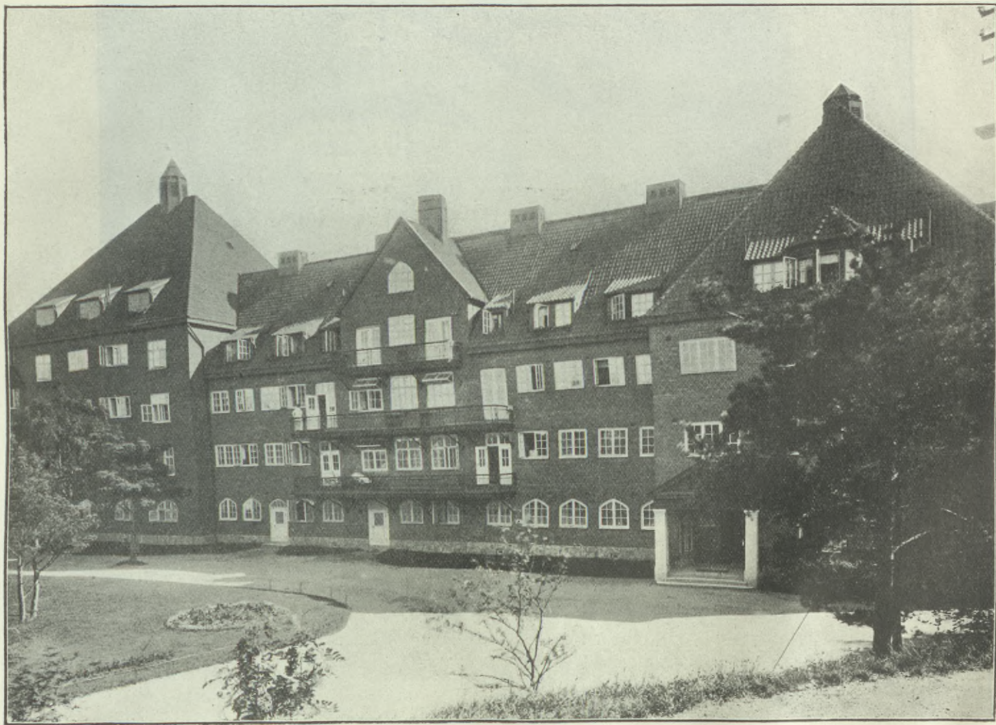
HUVUDBYGGNADEN FRÅN GÅRDSSIDAN.
