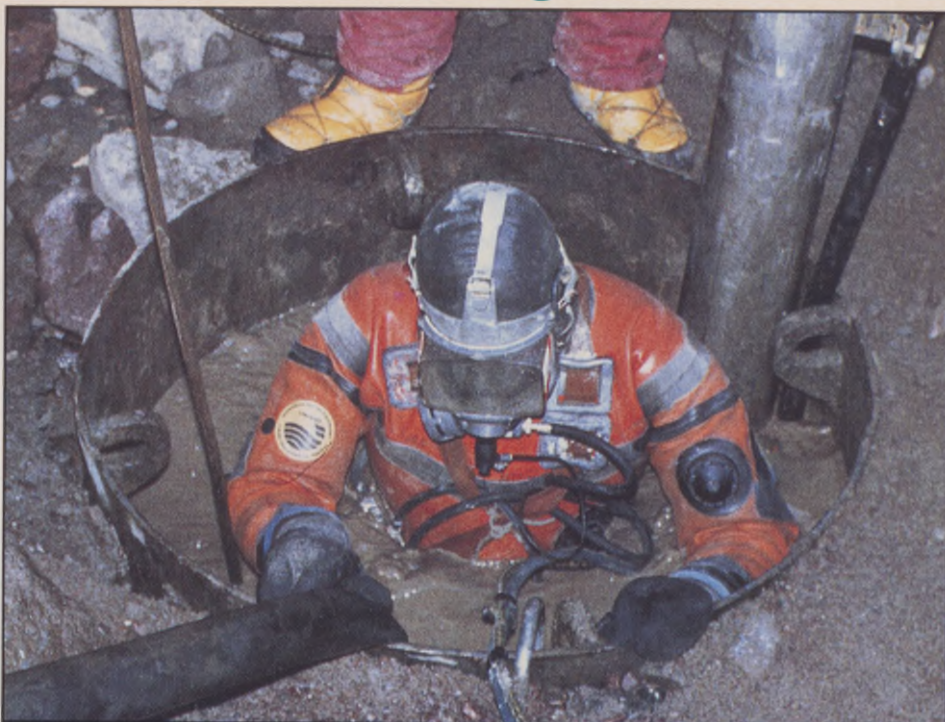
En uppfriskande simtur i en 12 meter djup tub. Bengt Ericsson gjuter för en betongpelare
