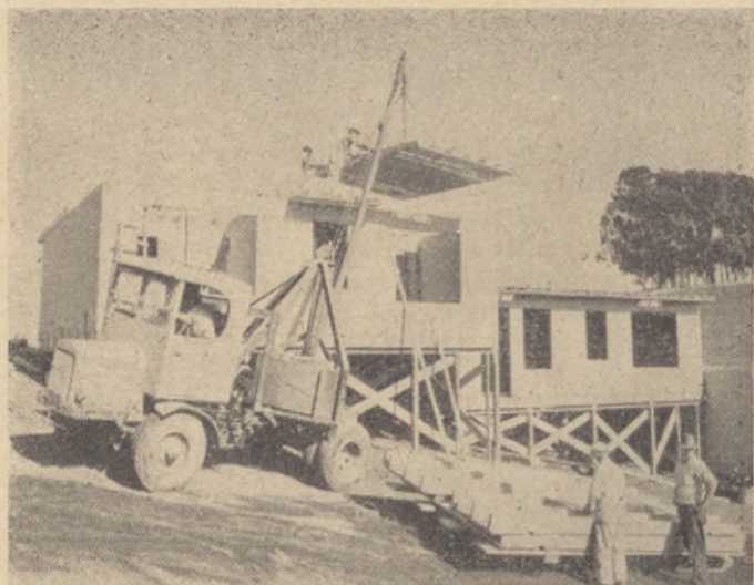
De färdigbyggda husen forslas på lastbilar till bestämmelseorten, och en mindre stad kan faktiskt byggas upp på tre timmar!
