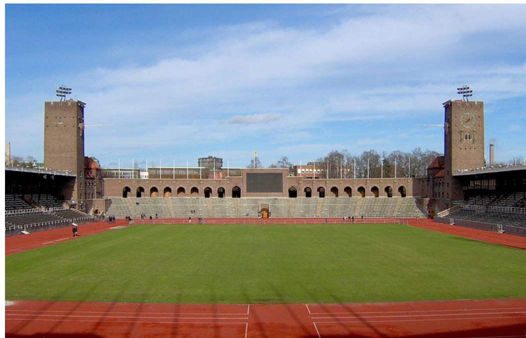
Figur 34. Anläggningen präglas av den nationalromantiska utformningen. Foto: Johannes Scherman, årtal okänt.
