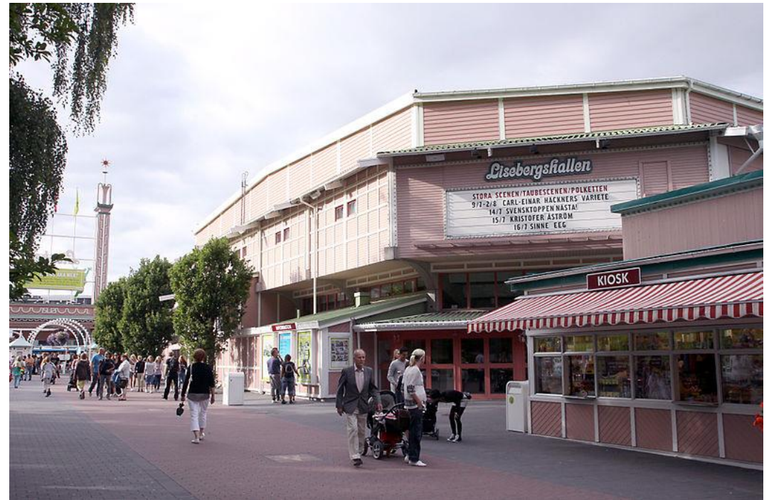
Figur 27. Lisebergshallen med sin liggande panel i en ljusrosa kulör revs på grund av Västlänken. Foto: Fluff, 2009.
