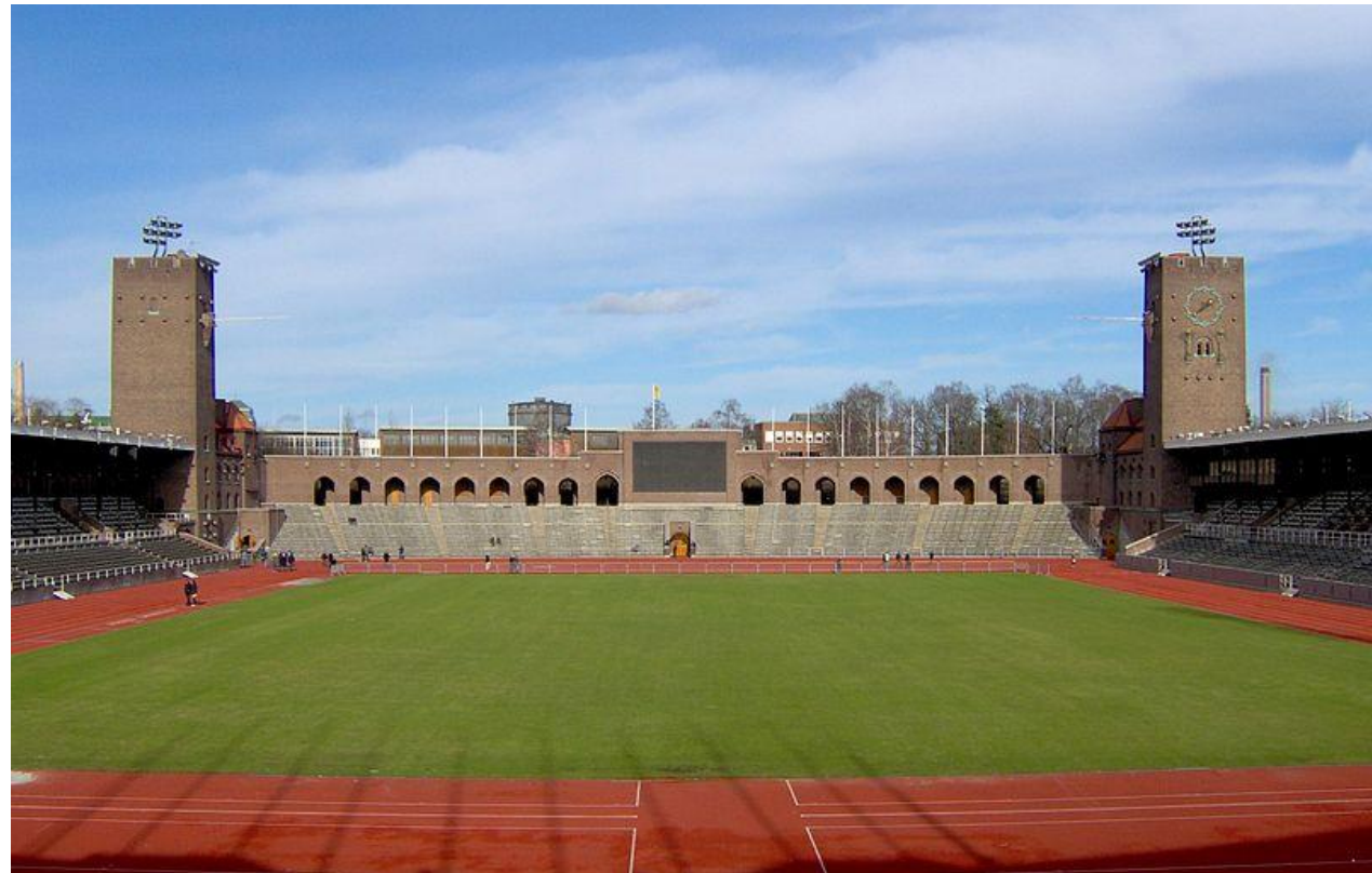
Figur 5. Stockholm stadion, byggnadsminne sedan 1990. Foto: Johannes Scherman, årtal okänt.
