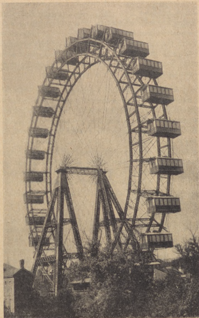
Riesenrad, Volkspratern, Wien. Det var detta hjul som man fick se i filmen "Tredje mannen". Riesenrad byggdes 1897, är 63 m. hög, har 30 vagnar och kan alltsomallt ta 600 personer.
