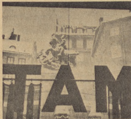
Kaféutsikt över S:t Göran och draken. "Mat" står det bakvänt på rutan. Det står "Öl" på nästa fönster. Ur "Stockholm bakom fasaden".
