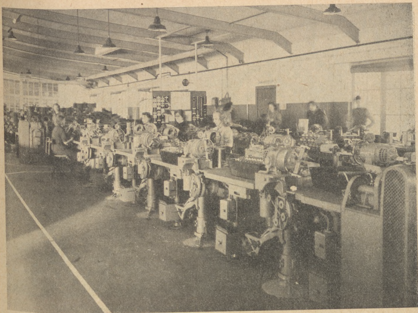
Från ASEA:s verkstäder i Västerås. Maskinhall, där man lindar små rotoror.
