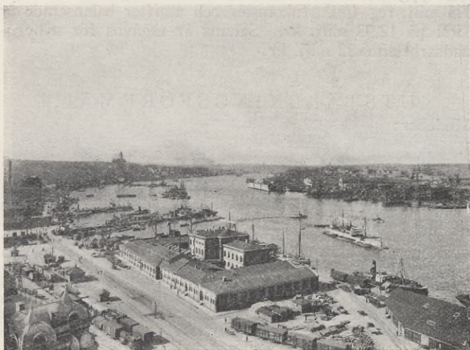
Hamnen sedd mot utloppet.
