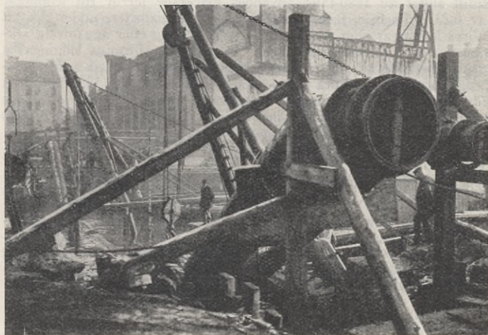
Dykareledning under Rosenlundskanalen.
