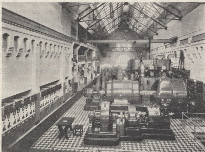
Maskinhallen i ångkraftsstationen.
