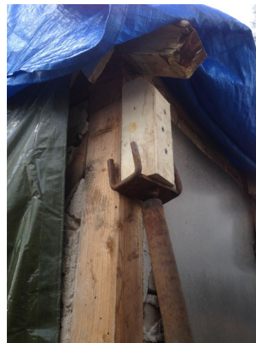
Figur 22 Detaljbild på stämp mot följare/kloss under bindbjälkshuvud. Foto. Jens Ingvad
