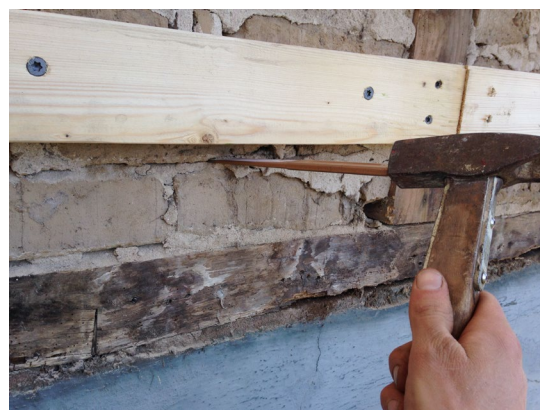
Figur 12. Med klohammare och huggmejsel knackas murskiftet ut. Foto Jens Ingvad
