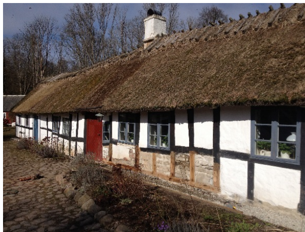
Figur 9 Exempel på fönsterkarmar som satts in efter sättning. Skevheten i korsverket påverkar inte byggnaden och en uppriktning av detta fyller ingen praktisk funktion utan riskerar att leda till en förvanskning av byggnaden. Foto Jens Ingvad
