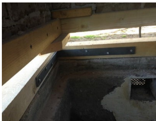
Figur 32. Hörn förstärkt med plattjärn. Foto: Jens Ingvad
