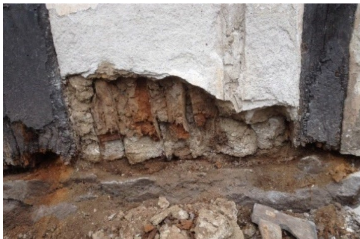
Figur 18 Klibbstakar i väggfyllning. Notera även avsaknaden av fotträ. Korsverk byggdes längre tillbaka ofta utan fotträ. Foto Jens Ingvad.
