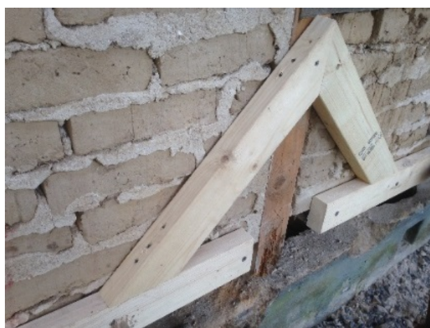
Figur 13 Facket är hängslat på stolpen. Foto Jens Ingvad
