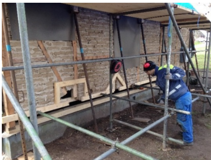
Figur 15 Röd pil: Stämp mot bindbjälksskalle. Grön pil: Rör spänt från ställning (se fig.) Foto: Jens Ingvad.
