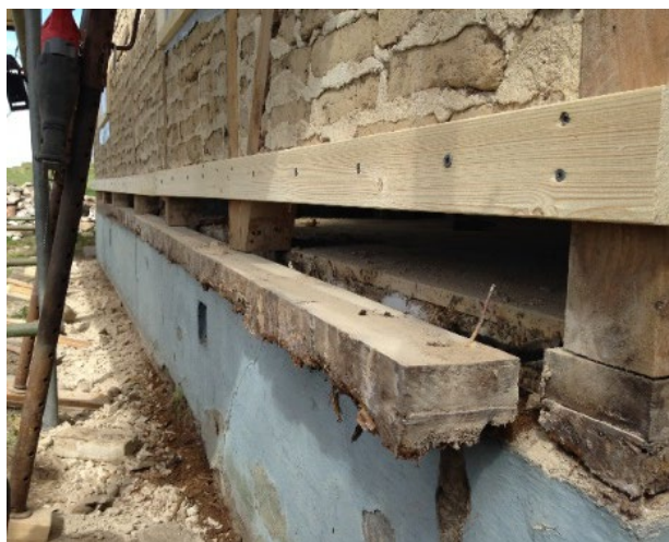
Figur 23 Stolpar och murverk har lyft precis tillräcklig för att det gamla fotträet kan plockas ut. Foto Jens Ingvad
