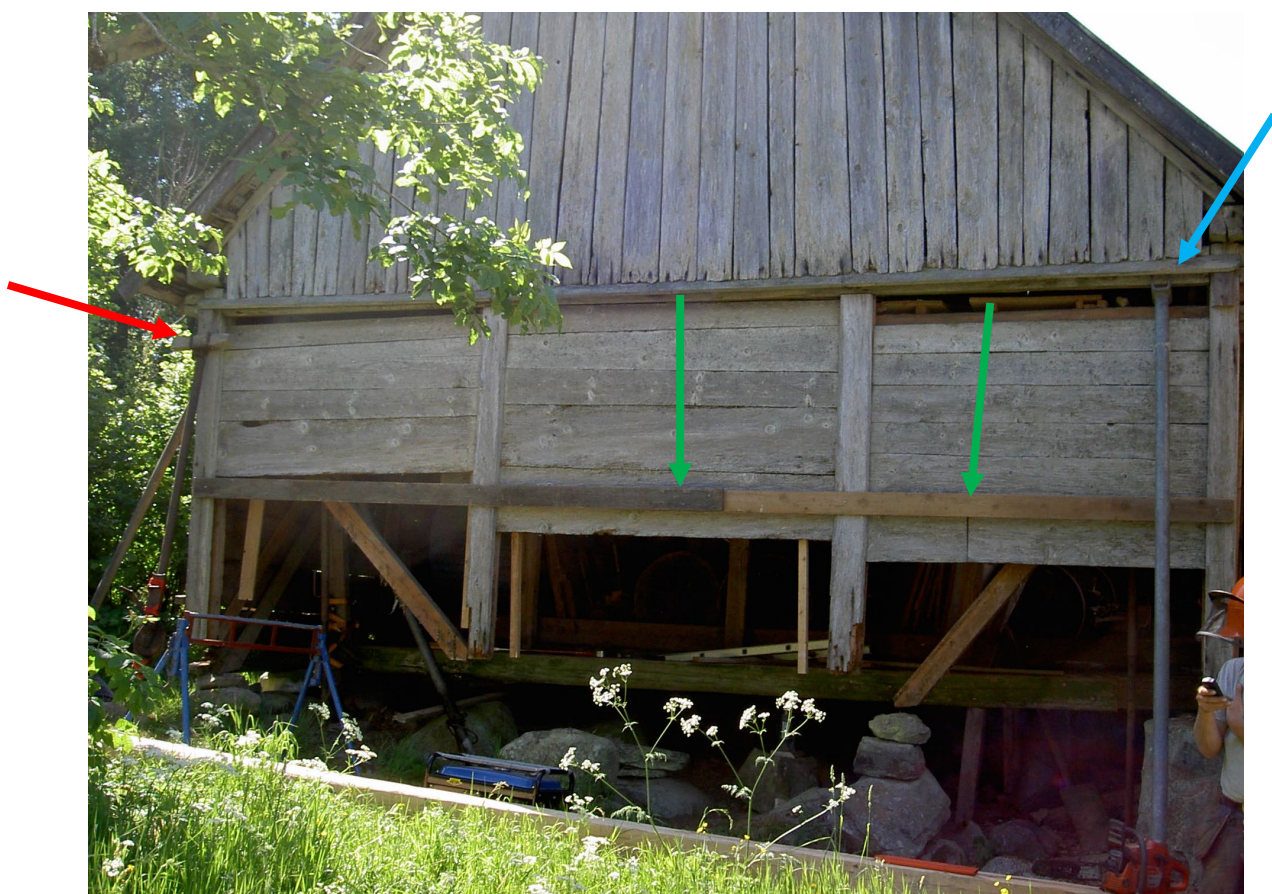
Figur 20 Byte av fotträ på gavel av en skiftesverkskonstruktion.
