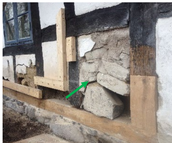
Figur 19 Grön pil: Alunskiffer. Nytt fotträ och stolplagning är på plats. Foto Jens Ingvad
