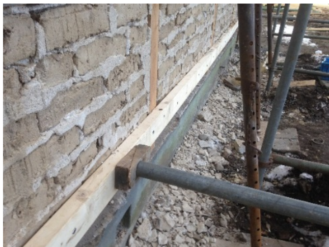
Figur 15 Röd pil: Stämp mot bindbjälksskalle. Grön pil: Rör spänt från ställning (se fig.) Foto: Jens Ingvad.
