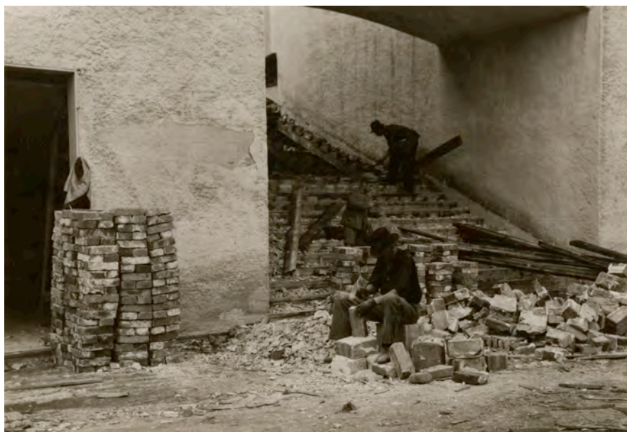
Figur 48. Allt har en början och ett slut. Männen på bilden destruerar en del av den omfattande Jubileumsutställningen i Göteborg. Byggnadsmaterial rensas, sorteras, tas tillvara och cirkulerar vidare. Kanske finns det spår i något arkiv om vad som hände med byggnadsdelarna som skulle symbolisera medeltida kyrkointeriörer? Foto: Göteborgs stadsmuseum.
