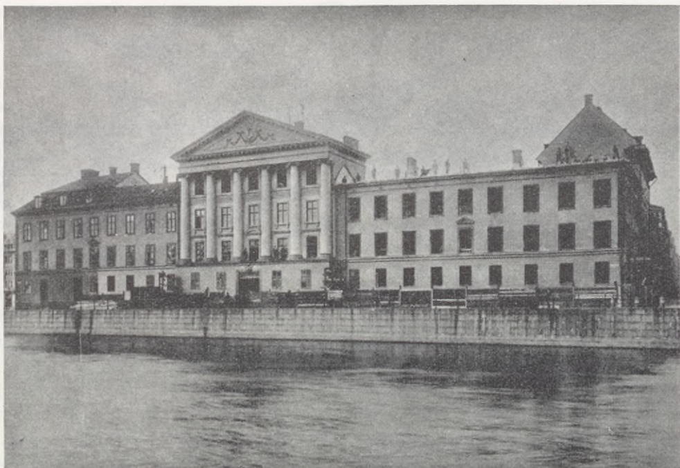
Det monumental Bondeska palatset vid Strömgatan, som på bilden just börjat rivas, byggdes omkring 1790 för greve Carl Bonde och revs för att ge plats åt det nuvarande Rosenbad, som blev färdigt 1902. Foto 1898.
