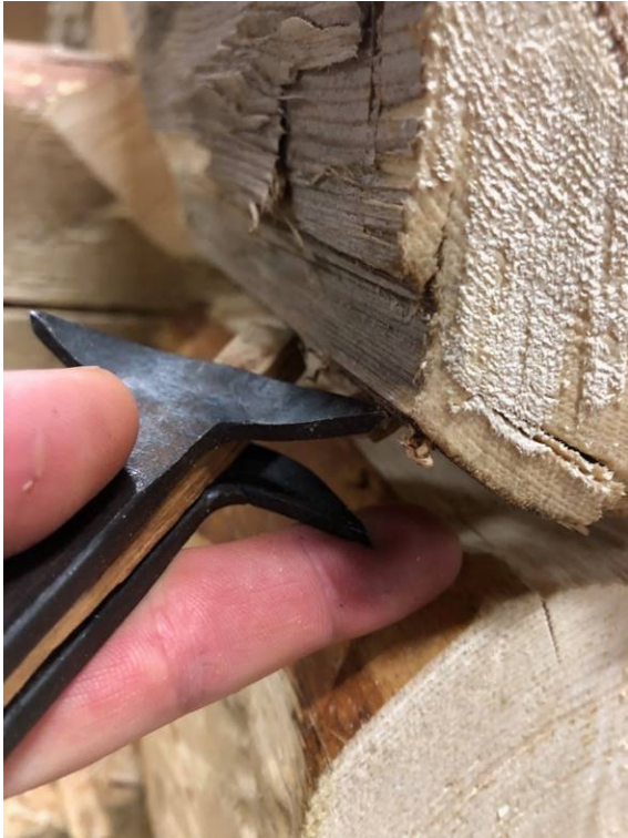
Figur 60. Ungefär ett finger ska kunna rymmas mellan knutskallarna, så här använder jag mitt finger som "distans".
