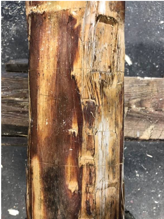
Figur 41. Den övre stocken är avplockad och vänds om från föregående bild (underhaket är uppåt). Markeringarna från den undre stocken är sammanförda med ritsar för att ge hakets bredd.
