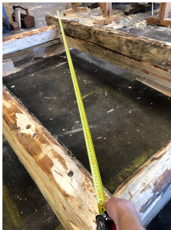
Figur 71. Med måttbandet kunde jag se det exakta måttet mellan spikarna i varje knuts syftade cc-mått.
