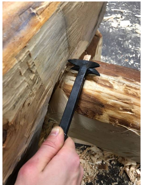
Figur 59. Den enda delen av knuten som går att dra med detta timmerdrag är ovanpå den undre knutskallen. Det går inte dra i det sneda haket för där när denna modell inte in.
