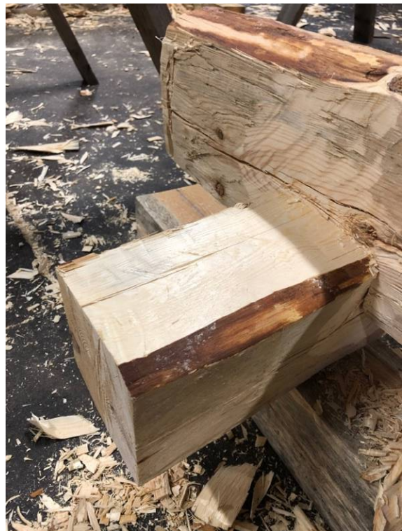
Figur 32. Färdig knut och knutskalle.
