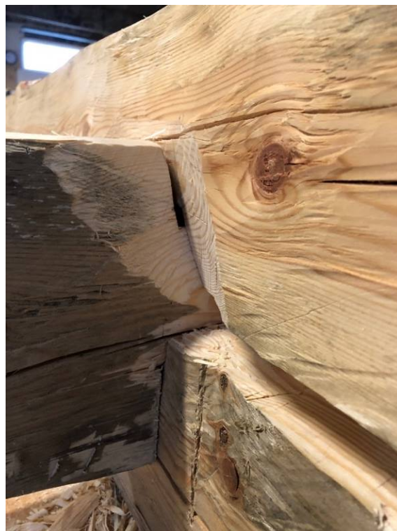
Figur 73. Otäthet i knut i andra varvet p.g.a. att jag har ögonmåttat centrum efter vridningen och inte lodet i hela stocken. I detta fall följer fasningen helt fel vinkel och har blivit "förflyttad" från lodet.
