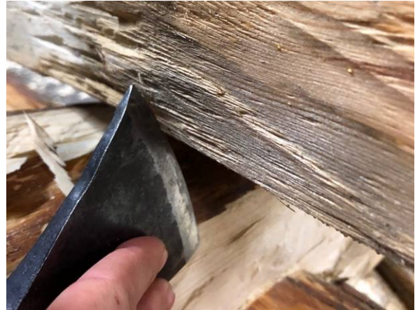
Figur 40. Bredderna på under och överstockarna överförs igen med hjälp av yxa alternativt kniv. Alla markeringar görs med liten marginal för långdraget.
