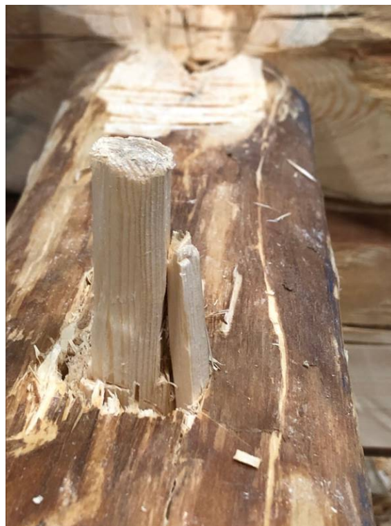
Figur 67. Dessvärre är detta mycket svårt och justeringar behöver göras med s.k. lusar som styr stocken i riktningen mot det förutbestämde lodet. På bilden syns också ritsen efter långdraget.
