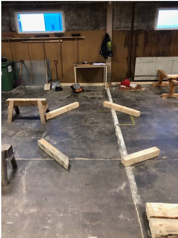
Figur 17. Pallningsmaterial utplacerat på arbetsplats.
