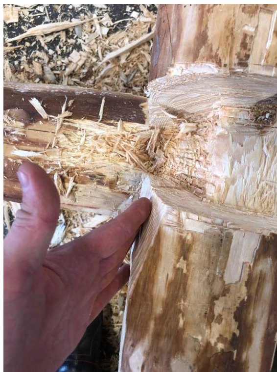
Figur 55. Efter att bredderna på fasningen är markerad kan man hugga klart det övre haket. Återigen kommer handflatan till nytta för att känna ojämnheter i överhakets fasningar.
