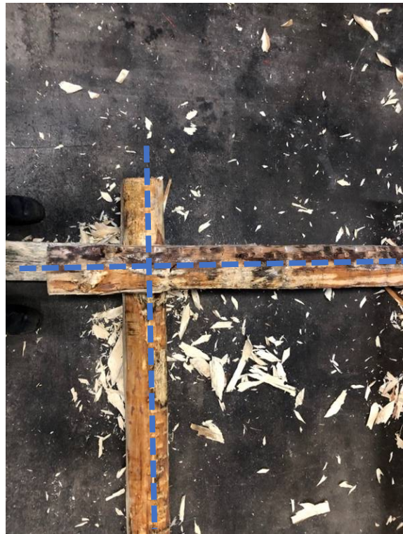
Figur 22. En illustration över hur de tänkta centrumlinjerna ska skära igenom varandra i 90°-vinkel.
