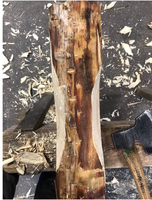
Figur 52. Färdighuggna och putsade fasningar på underhaket.
