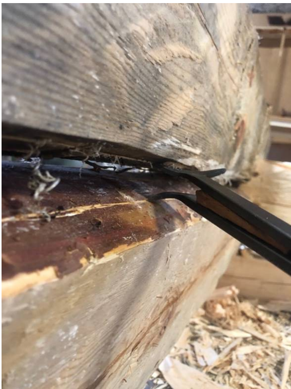
Figur 58. Mitt val av timmerdrag gör ritsar både nedåt och uppåt, det blir på så vis ett sätt att se om linjerna möts där man har dragit när stocken är helt sammanfogad. Det blir också ett kvitto på om man har hållit timmerdraget ur lod, för då kommer linjerna inte att mötas som de ska.
