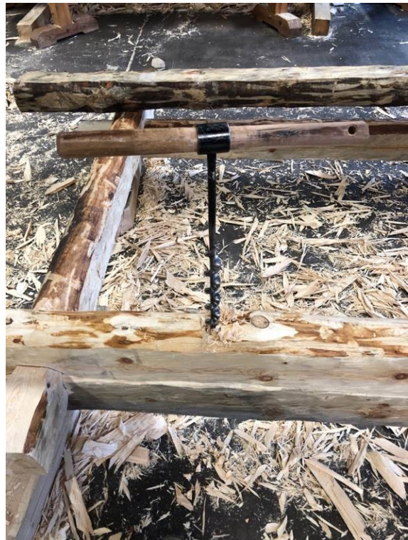
Figur 63. Spiralborr användes för att dymla igenom stockar, samma metod som används i modern timring fast idag görs det med bormaskin istället.
