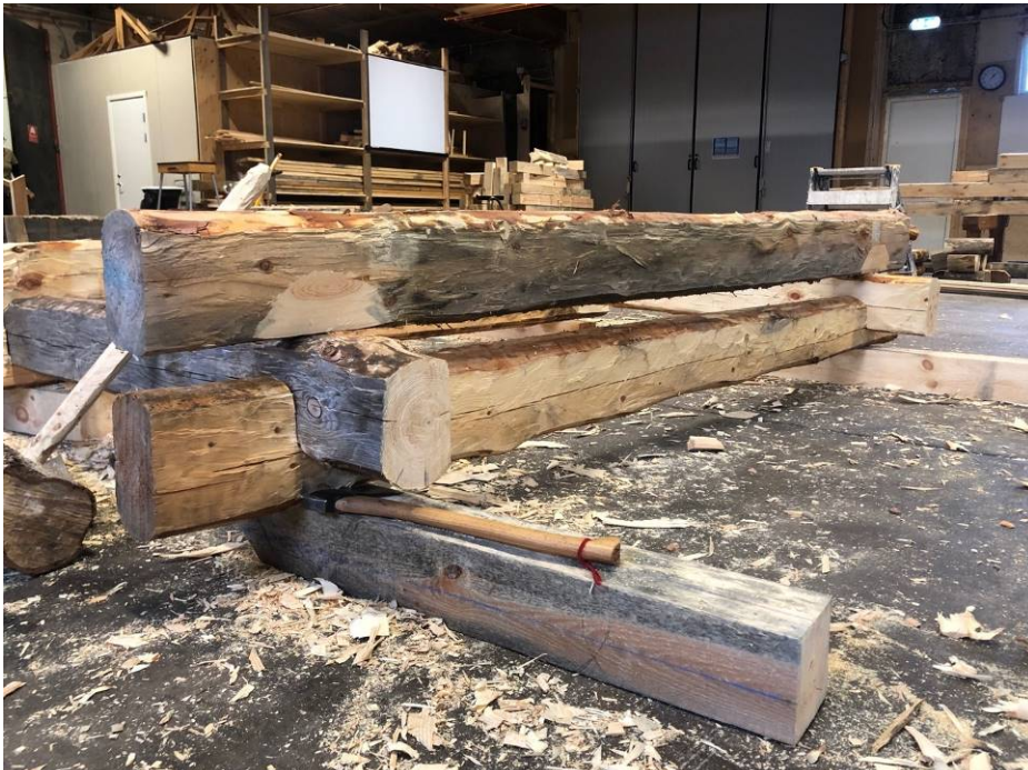
Figur 53. Den övre stocken vänds om i (förhållande till föregående bilder) och placeras tillbaka i sitt gamla läge för att föra över bredden på hakets botten i den undre stocken. Här får man försöka hitta sina första ritsar igen eller göra nya att gå efter.
