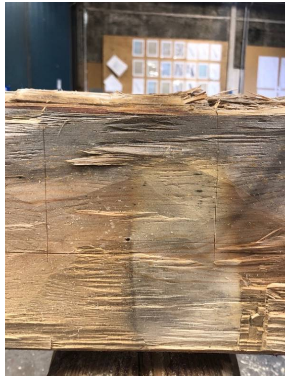
Figur 46. Jag ritsar ut hakets djup och bredd efter ögonmättat lod och våg.
