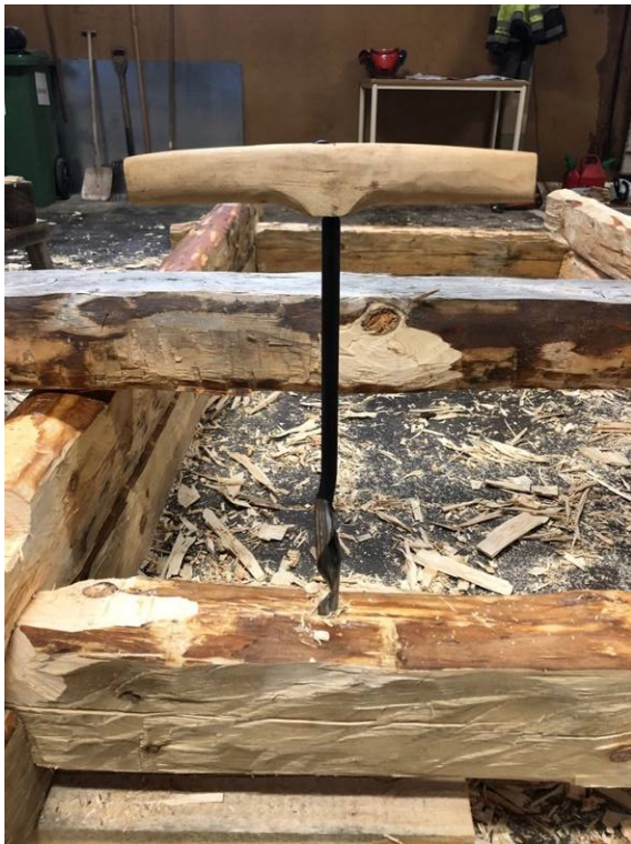
Figur 62. En spiralnavare användes för att dymla emellan stockar, även kallat för en "kortdymling" eller "dubb". Dessvärre fanns inte skedborr tillgängligt för undersökningen.
