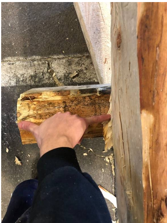
Figur 19. Den undre knutskallens längd mäts in med handen från änden på den undre stocken till sidan av den övre stocken.
