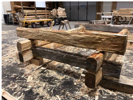
Figur 69. Foto från förundersökningen. Fotot är taget precis innan den sista stocken ska fällas ned i stommen.
