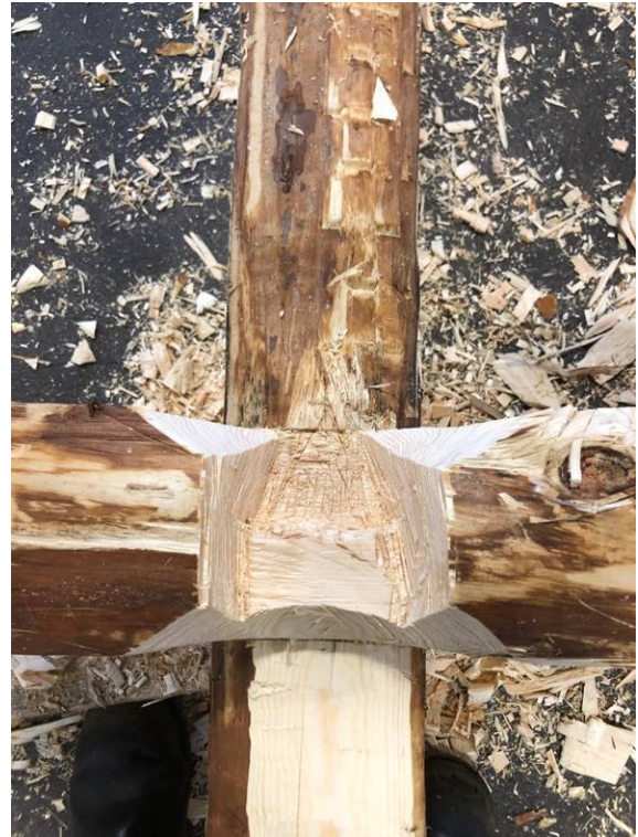
Figur 57. Grovhugget överhak redo för långdrag.
