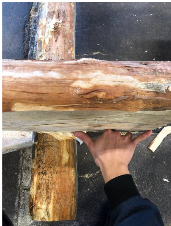
Figur 20. De övre knutsallens längd mäts in med handen från änden av den övre stocken till sidan av den undre. Dessvärre syns stockändan inte helt i bilden.
