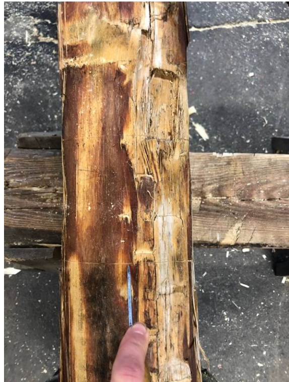
Figur 42. Centrum markeras med ögonmått. Här gjorde jag misstaget flertalet gånger att inte syfta centrum mot andra knutens centrum på motsatt sida av stocken. Det innebär att lodet inte hålls, utan skevheter byggs in i knuten/knutarna och stocken kommer inte följa sin bana i lod ner.
