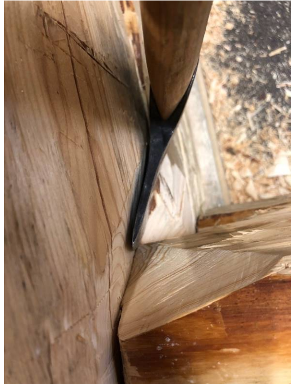
Figur 61. Den sista biten som ska dras är själva de sneda och fasade haken, här kommer jag endast åt med yxa eller kniv. Om yxan och kniven är ordentligt skärpta syns här en tydlig rits att följa efteråt.
