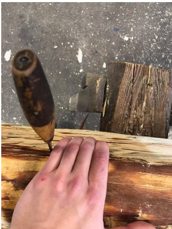
Figur 47. Fasningarnas längd från haket måttsätts med fyra fingrar.
