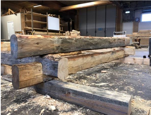
Figur 39. Stocken behövs vägas in i lod och placeras så som den sedan ska sitta slutgiltigt i den undre stocken.
