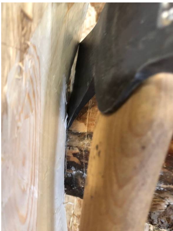
Figur 54. Bredden på den övre stocken förs över med rits från yxa alternativt kniv.
