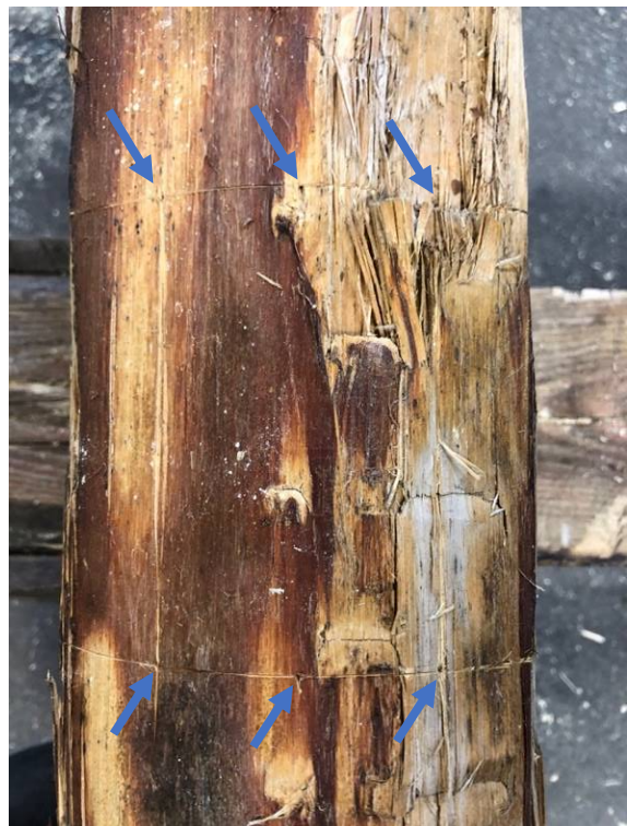
Figur 44. Färdig mätsättning av hak. Markeringarna/ritsarna är svåra att se på bilden och är förtydliga med pilar.
