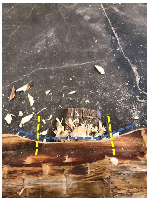
Figur 50. Vinklarna syftas i linje (blå markering), för att se att ytorna är plana. Inom de gula markeringarna ska haken mötas och därför är det extra viktigt att det är plant mellan dessa markeringar.
