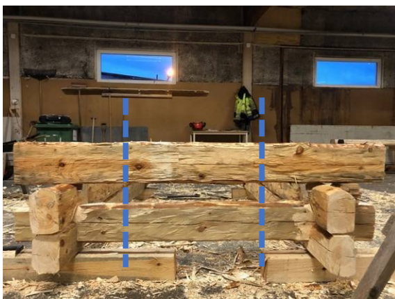
Figur 64. En stock som är redo för att dymlas (i detta fall prövade jag att grovhugga överhaken först för att få ner den övre stocken något). Målet är att dymlingarna ska vara parallella med de markeringar som är illustrerade på bilden så att lodet ska hållas hela vägen ner i färdigt långdrag.
