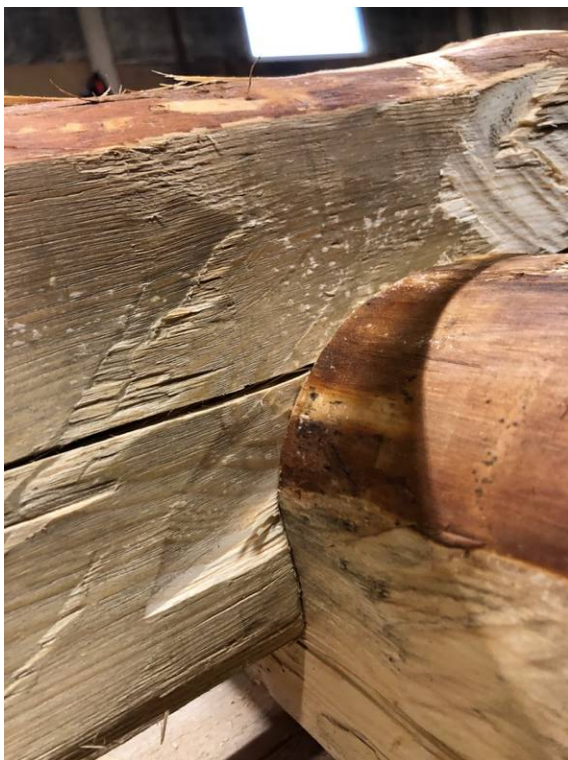
Figur 33. Godkänd täthet mellan knutens hak.
