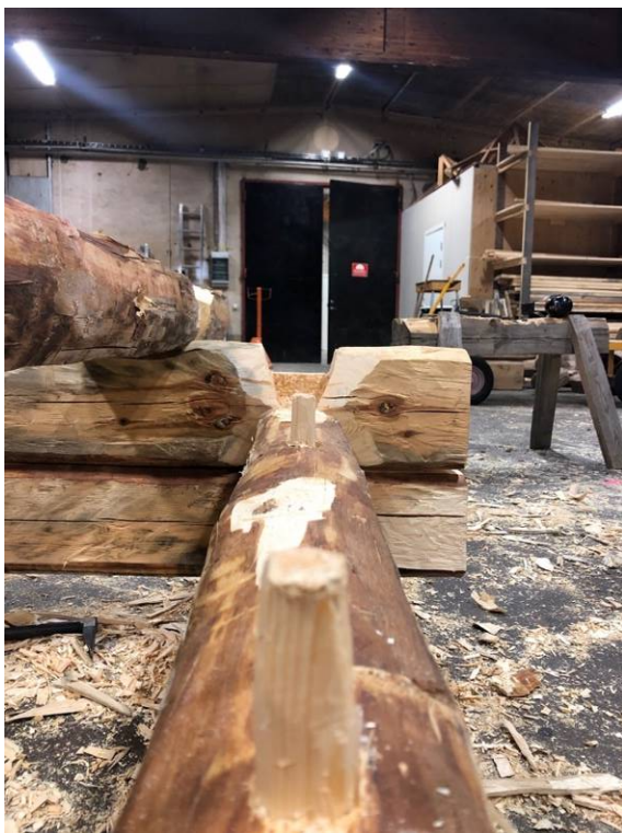
Figur 66. Den undre stocken är dymlad och den övre har borrade hål som ska passa perfekt.
