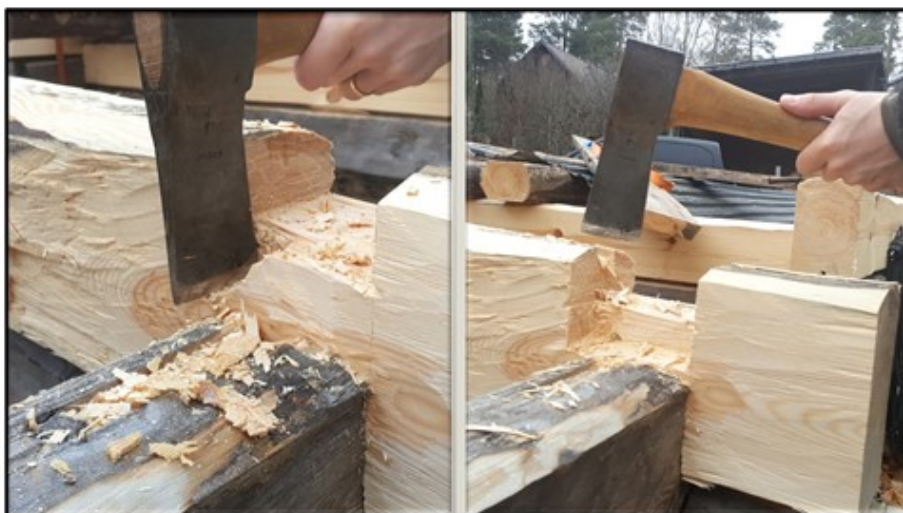
Figur 5 Moment 3. Mossrännan och inhak huggs ur. Inhaket huggs "på höft" (EU 6869). Cirka 1 ¼" (EU 5221).
