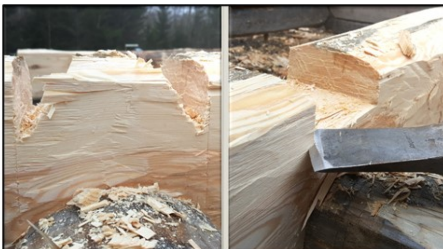
Figur 4 Moment 2. Överhaket huggs till halva uppstickets höjd (EU 5221; Nordiska museet 1928). Bottenmarkering görs med huggyxa i hakets fyra hörn (EU 5221).
