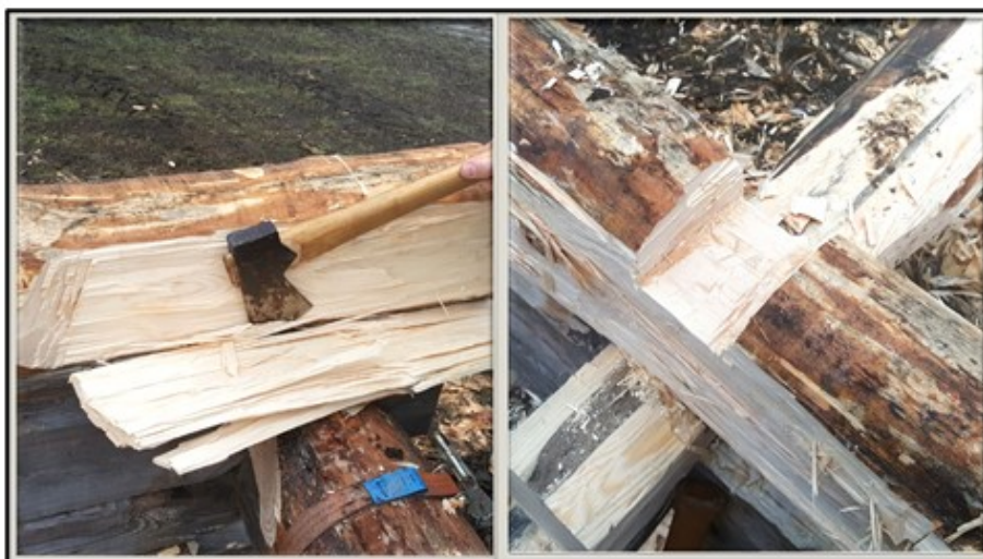
Figur 8 Moment 6. Kinningen sker med förhugg och späntring med huggyxa och täjls med täljyxa cirka två fot från stockändan mätt. Underhaket huggs med ett ungefärligt djup (EU 5221).
