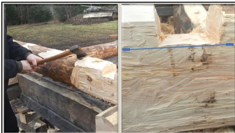
Figur 11 Moment 9. Stocken vänds, draget huggs med huggyxan och underhaket fördjupas, med stocken liggande i överhak (EU 3970; EU 5221; EU6869; Nordiska museet 1928). Blå markering visar hur nära sitt slutgiltiga djup haket var efter att det höggs provisoriskt i moment 6.
