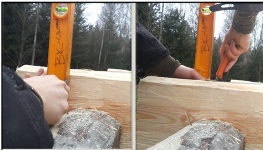
Figur 3 Moment 1. Överhak markeras ut med hjälp av lodbräda/vattenpass mot vägg (EU 3970; EU 5221; Nordiska museet 1928)
