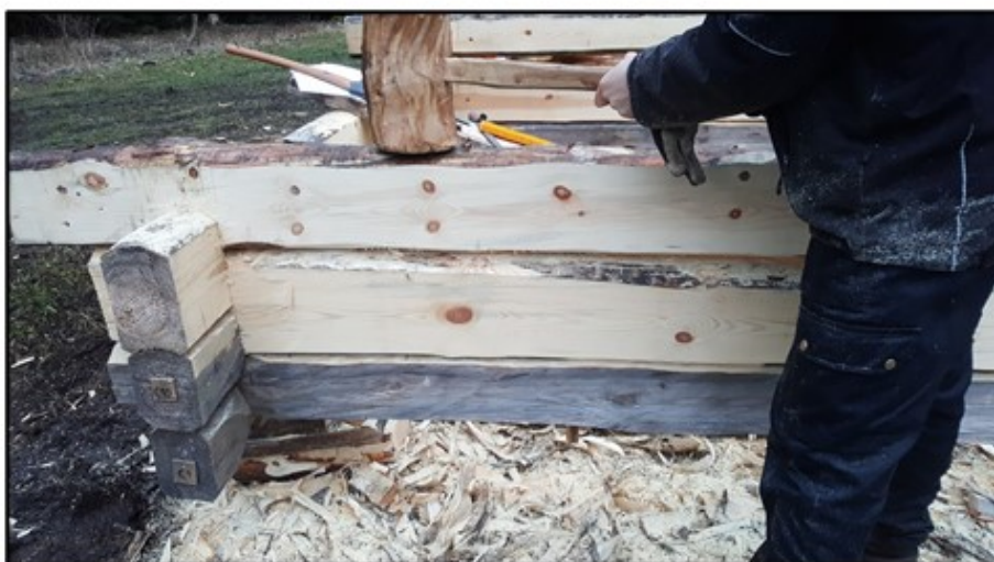
Figur 25 Moment 11. Stocken vänds på nytt. Sidorna justeras med täljyxa för att få ner den ordentligt.
