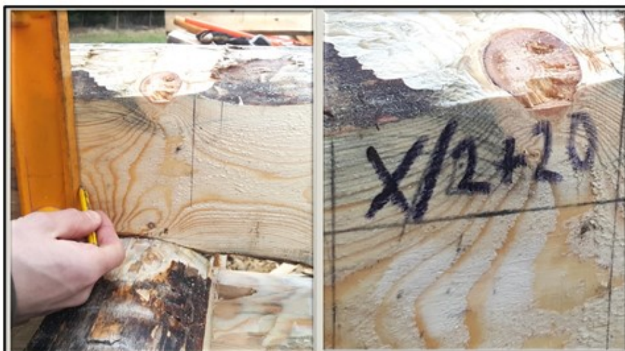
Figur 19 Moment 5. Nästa stock läggs i överhaket uppochned. Måtten förs över från understock. Glöm ej att lämna material till att gå in i inhaket, men lämna ett mellanrum nära tröskeln. Ingen beskrivning av underhakets djup fanns, så det togs till halva uppsticket plus 20 mm på eget bevåg.
