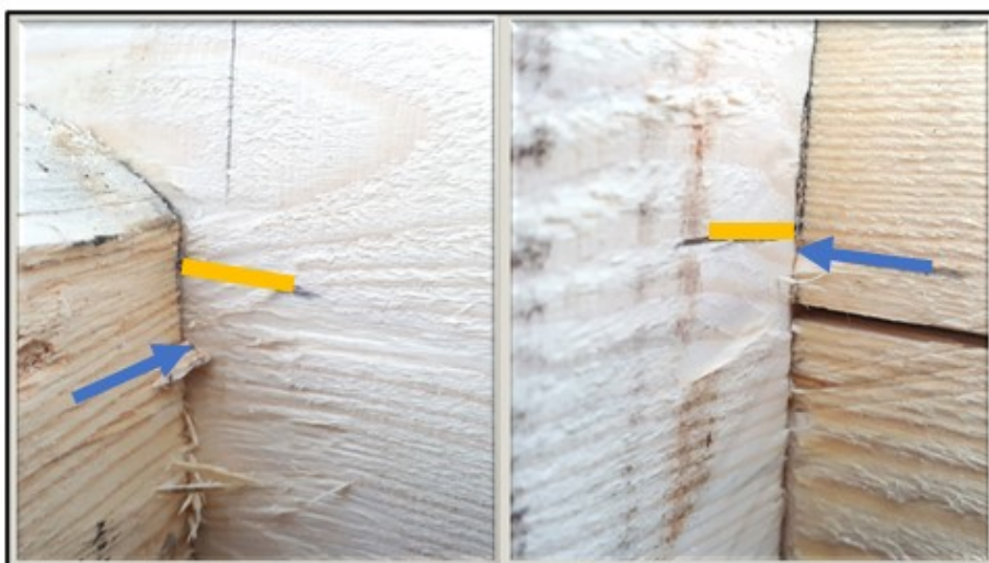
Figur 26 Resultatet av att underhaket sattes ut bara en gång vid båda knutarna. Ingen påmärkning av tröskelhöjden skedde när stocken drogs. De gula, förstärkta strecken är markeringar för underhakets djup i övre stocken vid båda knutarna. Pilarna visar tröskelhöjden på undre stocken.
