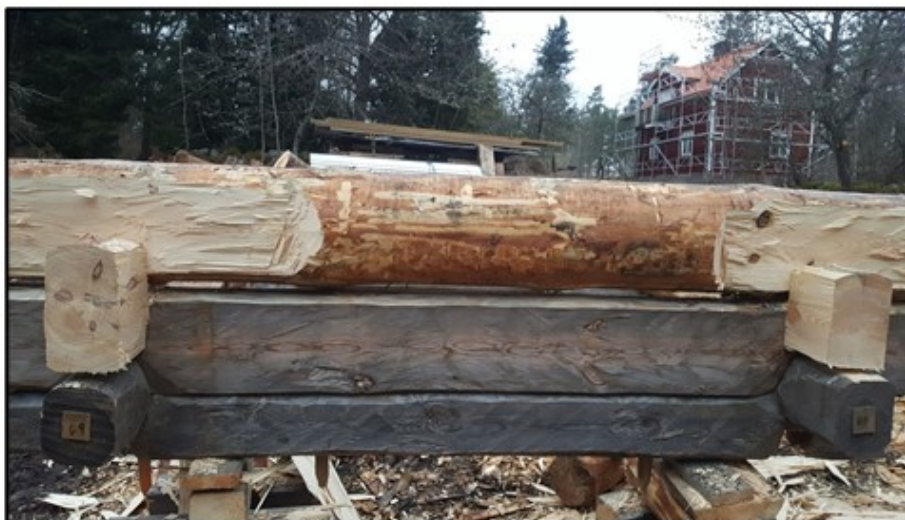
Figur 9 Moment 7. Stocken vänds och klubbas ned i undre stockens överhak (EU 3970; EU 5221; EU 6869; Nordiska museet 1928). Eventuellt fördjupas underhak och avjämnas stockarna för att ligga nära varandra när stockarna ska dras (EU 3970; EU 5221).
