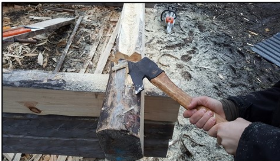
Figur 24 Moment 10. Knutskallarna huggs av i underkant för ett glapp på 5 millimeter mellan varandra.
