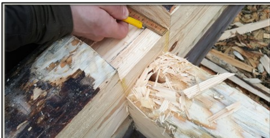
Figur 17 Moment 3. Mät på tröskeln för inhaket. Inhakets djup från kant: 35mm
