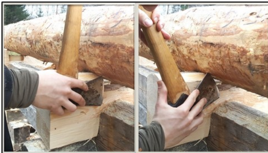
Figur 6 Moment 4. Ny stock läggs med undersida ned och när den ligger mitt ovanför undre stockens överhak markeras kinning och underhak med huggyxan (EU 3970; Nodiska museet)
