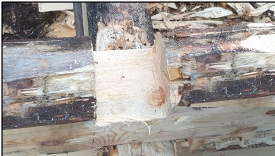
Figur 20 Moment 6. Underhaket sågas med motorsåg exakt vid linjerna. Klossen spräcks loss med yxa och underhaket avjämnas med stämjärn.
