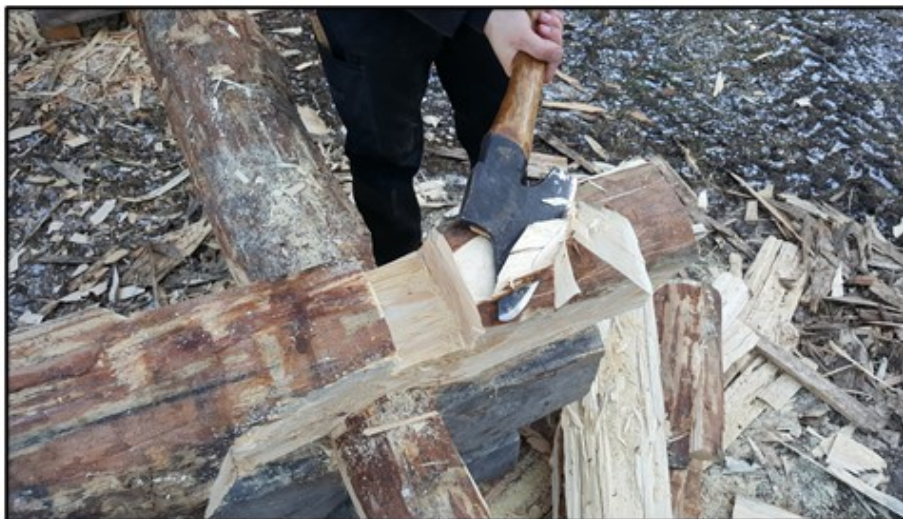
Figur 12 Moment 10. Knutskallens undersida avjämnas med täljyxan (EU 5221)
