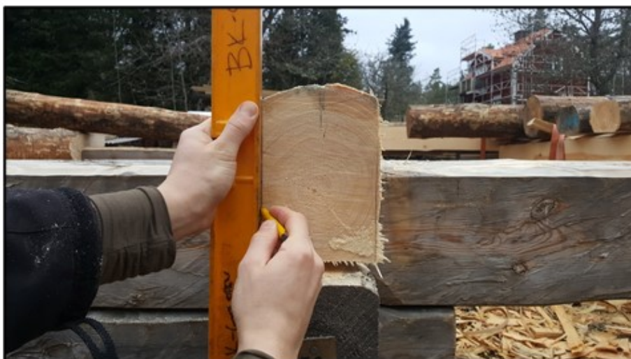
Figur 14 Moment 12. Sidorna lodas upp och ritas på ändträet, samt avputsas (EU 3970). Knutskallens ände märks ut med vattenpass och kapas (EU 5221). Ingen kapning utfördes i detta fall.
