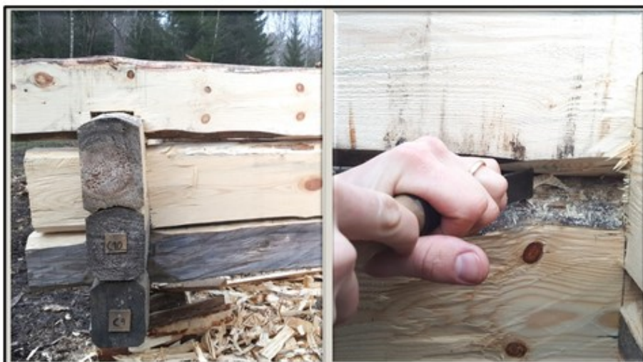
Figur 22 Moment 8. Överstocken drivs ned att ligga an mot understocken. Långdraget dras med stämjärn. Målet är 80-90mm brett långdrag om timret är 150-160mm.
