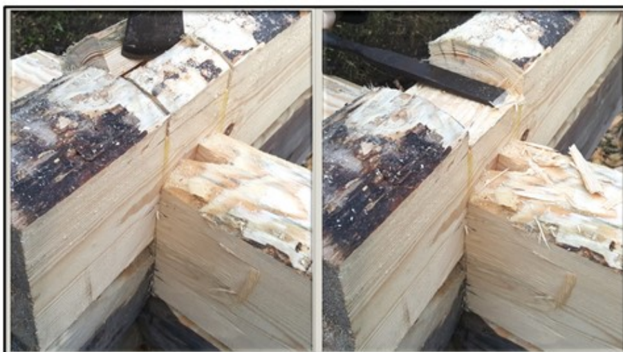
Figur 16 Moment 2. Halva uppsticket märks ut med vågstreck. Såga med motorsåg några millimeter innanför linjerna. Överhaket ska avsmalna något nedåt. Klossen spräcks bort med yxa och överkant tröskel avjämnas med stämjärn.
