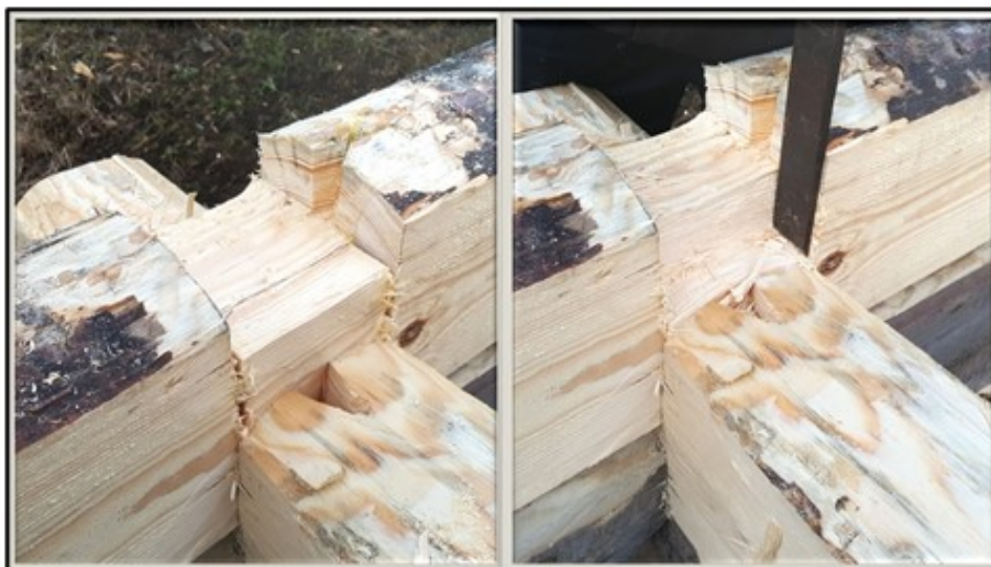
Figur 18 Moment 4. Inhakets sidor sågas med motorsåg, avsmalnande även här. Mossrännan sågas med motorsåg och inhaket huggs ur med stämjärn.
