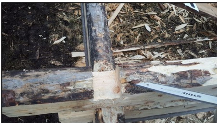
Figur 23 Moment 9. Stocken lyfts och läggs uppochned i överhaket. Långdrag sågas med motorsåg.
