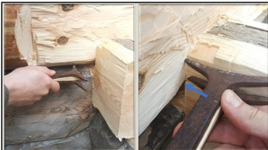
Figur 10 Moment 8. Stocken dras med timmerdraget för långdrag (EU 3970; EU 5221; EU 6869; Nordiska museet 1928) Knuten "dras" med sjunkmån (EU 5221; EU 6869). Blå pil visar tröskelhöjd.
