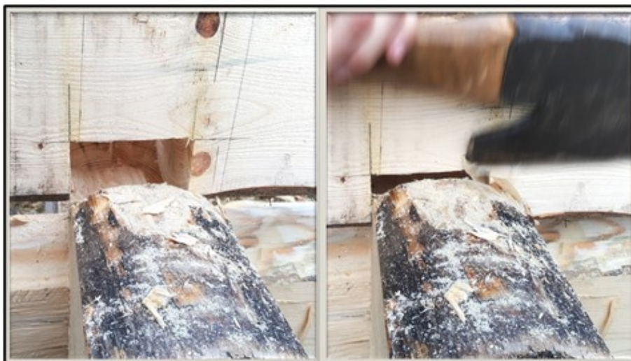
Figur 21 Moment 7. Stocken vänds och överstockens sidor täls så att den sjunker ned i överhaket på undre stocken.
