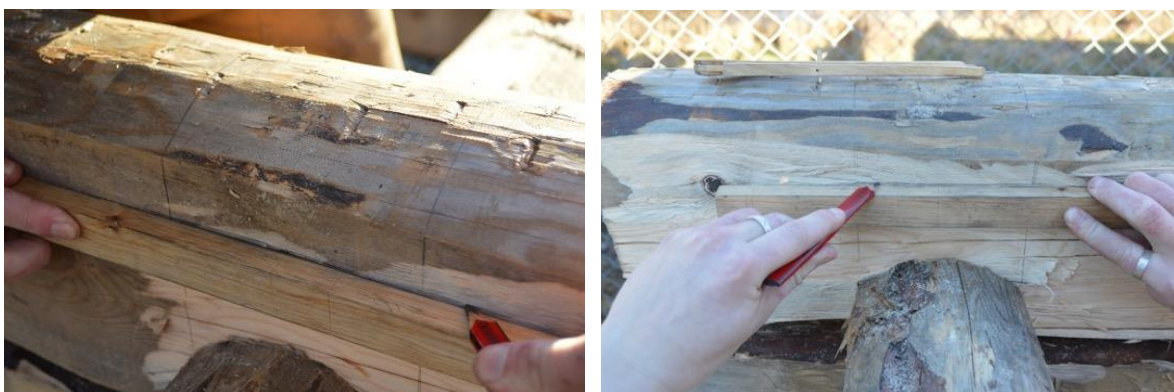
Figur 25 Tröskeln markeras ut på överhaket med måttstocken som guide. Våg fluktas. Foton Elin Grahn
