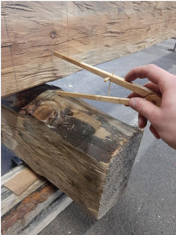
Figur 69 Bygelns längd gav passaren begränsning i bredden mellan spetsarna. Så försökt till att inte få allt för höga uppstick och inte använda grövre stockar än vad passaren kunde ta.
