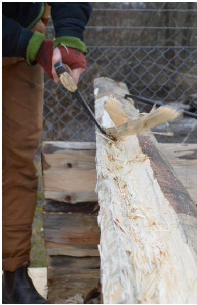
Figur 52 Knutyxan används för att hugga ur långdraget. Foto Elin Grahn.
