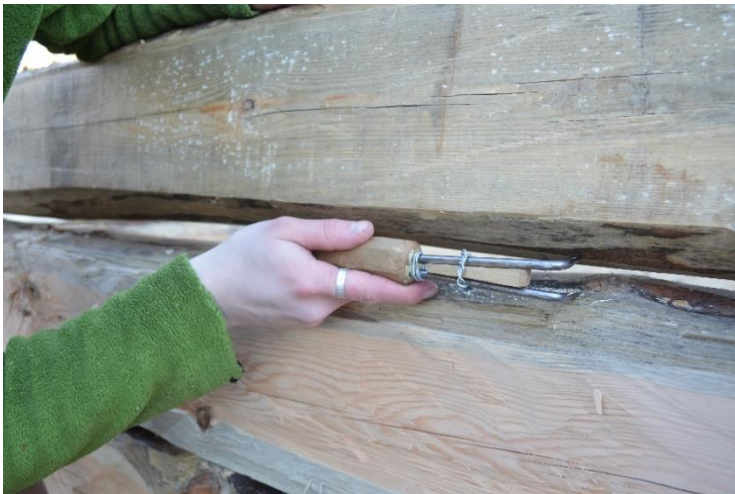
Figur 40 Här testas timmerdraget (T2) mot stockarna för att se vilken bredd som behövs för att kunna få en rits jämnt över stocken. Den styrande faktorn vid dragningen påverkar hur mycket varje väggstock sjunker och beroende på formen av stocken blir den sjunkningen olika mycket.
