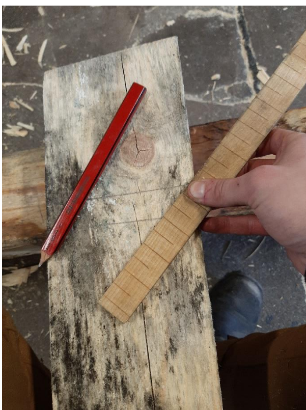
Figur 33 Från en tums markering dras en vinkel ut till noll.
