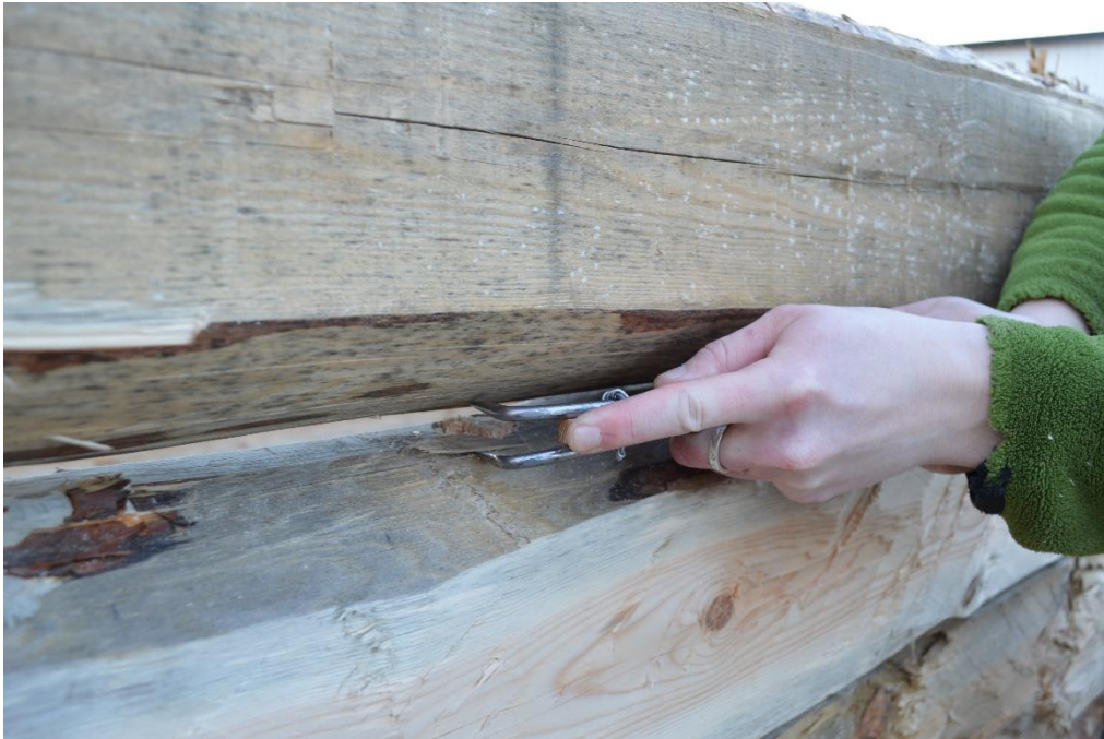
Figur 75 Timmerdraget enbart för att dra långdrag, markera ny tröskeldjup i överstocken. Och luft mellan knutskallarna. Foto Elin Grahn
