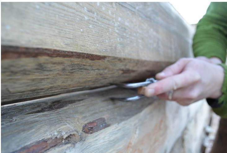
Figur 42 Då spetsarna inte är härdade på draget (T2) påverkade materialets yta mycket resultatet på ritsen. Om ytan hade mycket smuts och grus i sig så blev draget fort slött och gjorde ingen bra rits. Men för vasst vässade spetsar hade den nackdelen att då följde med fibrerna i den undre stocken istället för att bara ligga an och följa med.
