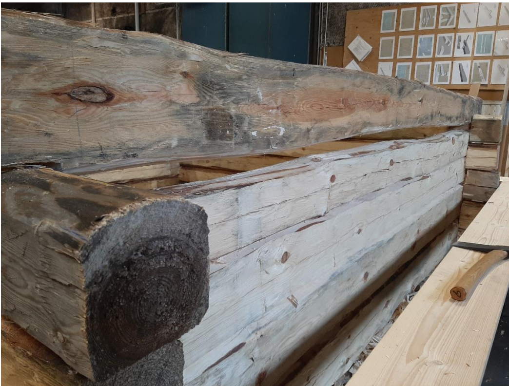
Figur 65 bredden på draget - placeringen av stocken - påverkar vilket drag som är möjligt att använda - påverkar utformningen vid tillverkning.
