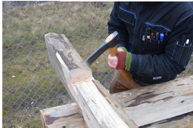
Figur 53 Knutyxan används för att justera underhaket i överstocken. Foto Elin Grahn
