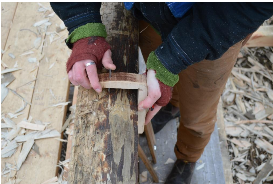
Figur 76 Timmer - riet testades inte så mycket i andra sammanhang då det inte behövdes för andra delar än markera för dymlingar. Foto Elin Grahn
