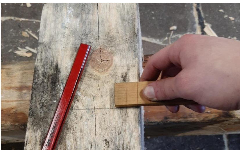
Figur 32 En tum in markeras på var sin sida.
