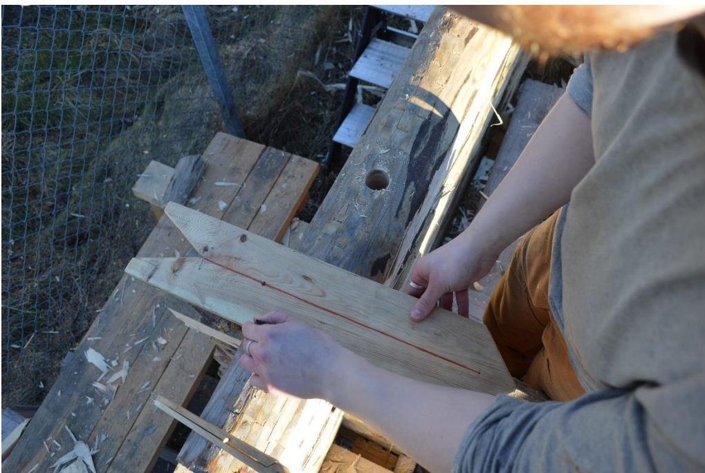
Figur 64 Bredden på timret - Bredden på lodbrädan - Bredden på överhaket. Foto Elin Grahn
