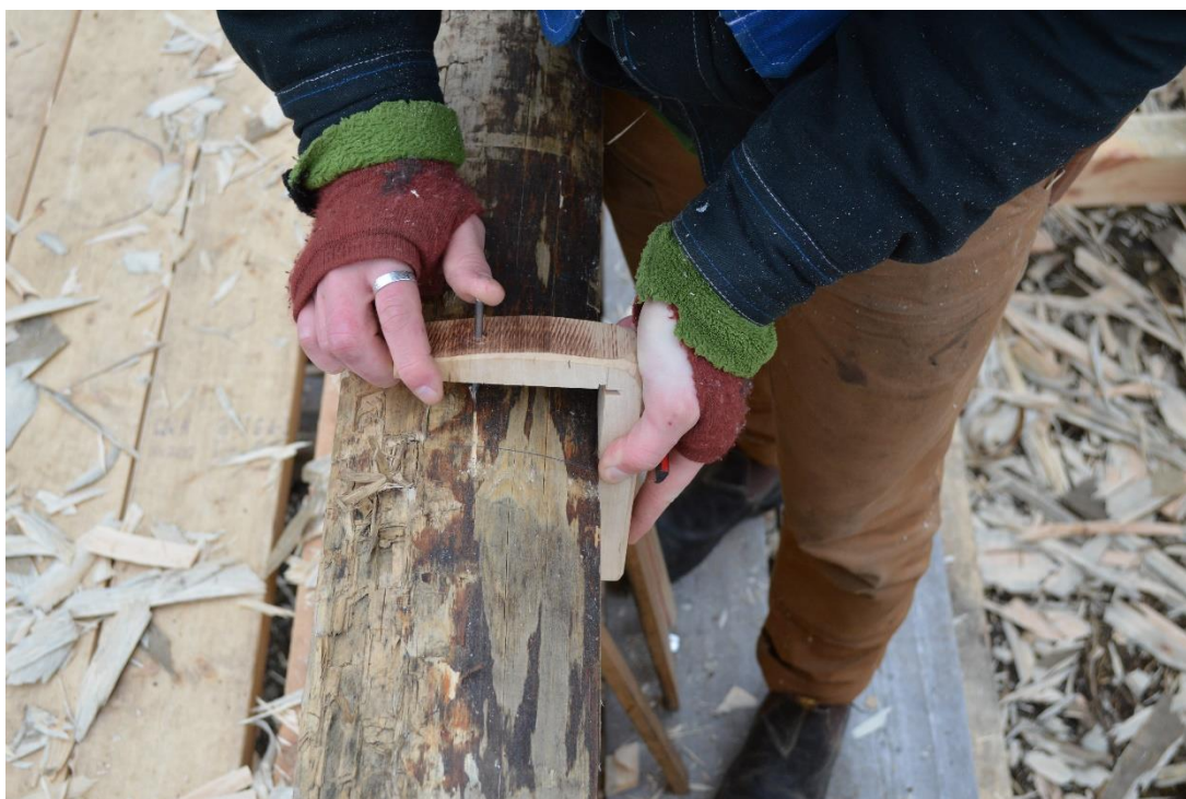
Figur 37 Timmer - riet används för att markera en centrumrits för en dymling. Foto Elin Grahn
