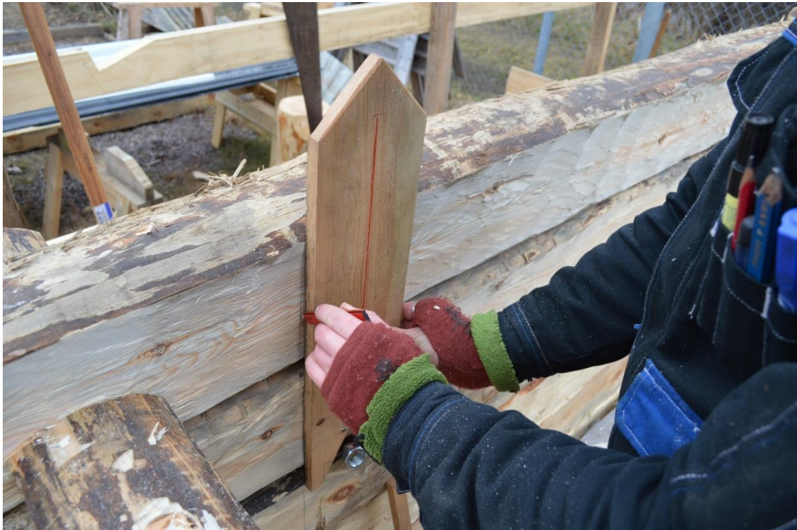
Figur 17 Här lodas dymlingsmarkeringen upp för att sedan föras upp på rundningen. Foto Elin Grahn
