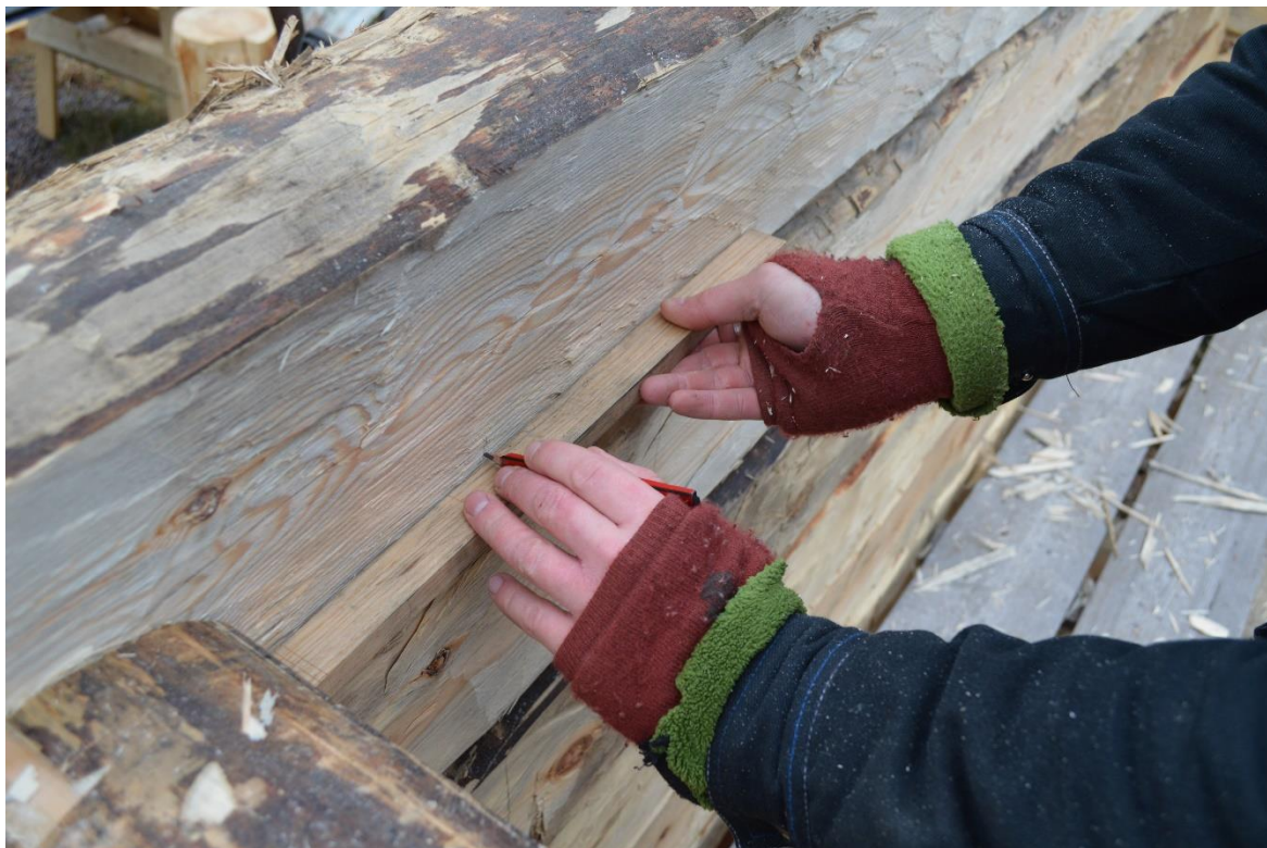
Figur 29 Mättstocken används för att markera för dymling. Dymlingarna sattes mellan två mått. Varannan markering per stock. Foto Elin Grahn
