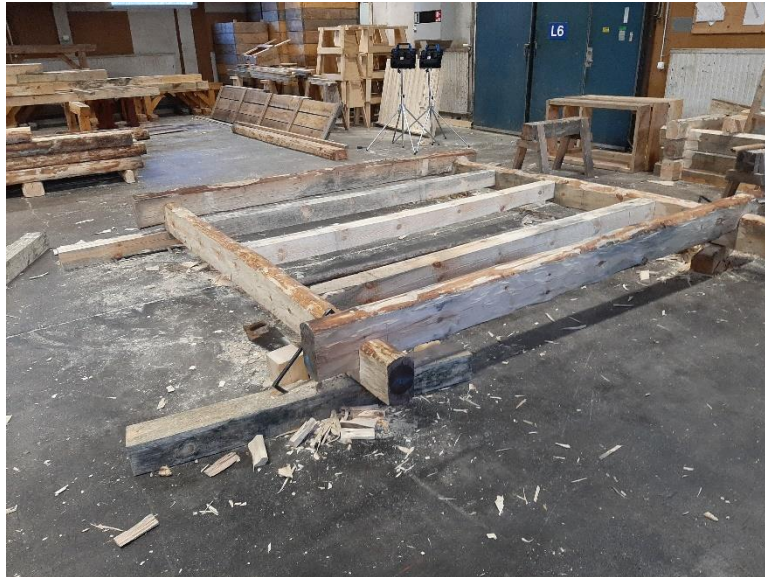
Figur 50 Syllvarvet lagt och golvbjälkarna infällda.
