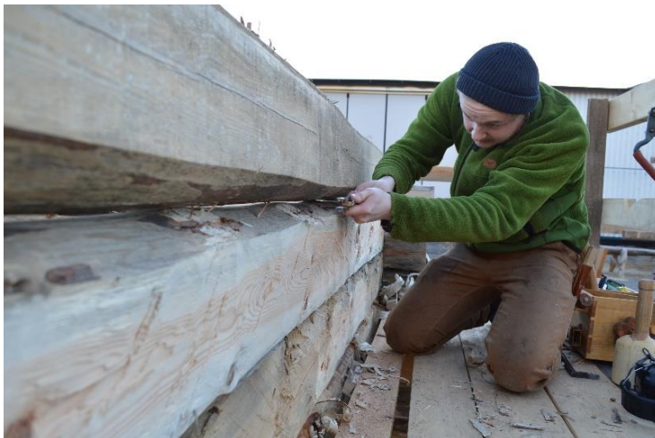
Figur 43 Hur draget hålls blev en faktor i hur lätt det är att få klorna att vara parallella med varandra. Det som jag lade märke till är att ju längre delar ett drag har som ett långt handtag eller skaft gör det lättare att se till att klorna hålls parallella. Gav en tydligare referens. Detta blev väldigt tydligt när jag drog med knutyxan (Se Fig. 20) och skaftet blev en tydlig indikator på om jag höll den i lod. Foton Elin Grahn
