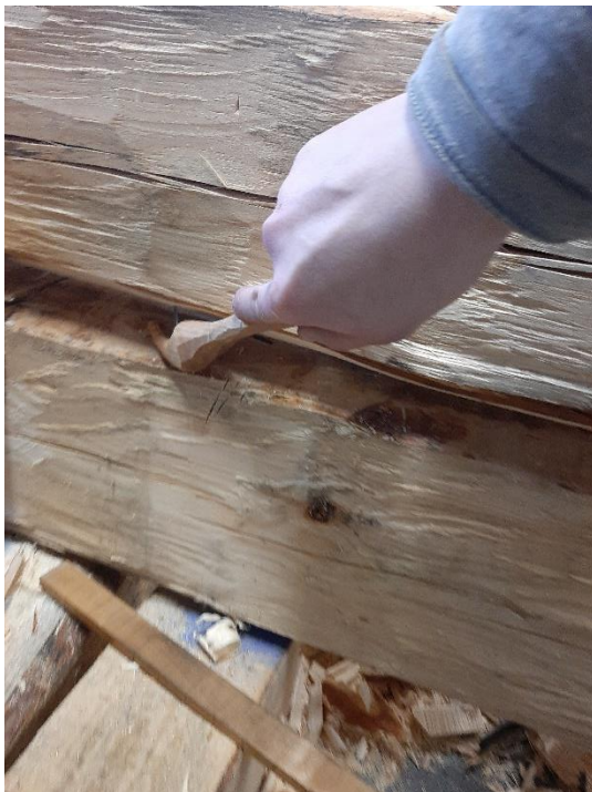
Figur 45 Den andra av dragen används (T1). Med försökt till att efterlikna som det dras på bilden. Det som inte gick med detta drag var att försöka hålla draget på samma sätt från den ena sidan till den andra. Påverkan av hur stor vankant eller inte påverkade också om det ens gick att hålla den i samma position. Även att hitta en parallell punkt på anhållet och ritsen var svår att se och skiftade även beroende på hur nära understocken låg den övre. Kanske ska detta drag fungera som ett beskrivs i Timmerbyggnader (Andersson, 2016, ss. 220) Eller så blev något fel vid tillverkningen.
