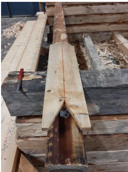
Figur 71 Funktionen av lodbrädan blev mer än avsatt från början. Användes som mall vid knutning, måttstock för fönster - dörröppningar, loda upp markeringar för dymlingar.
