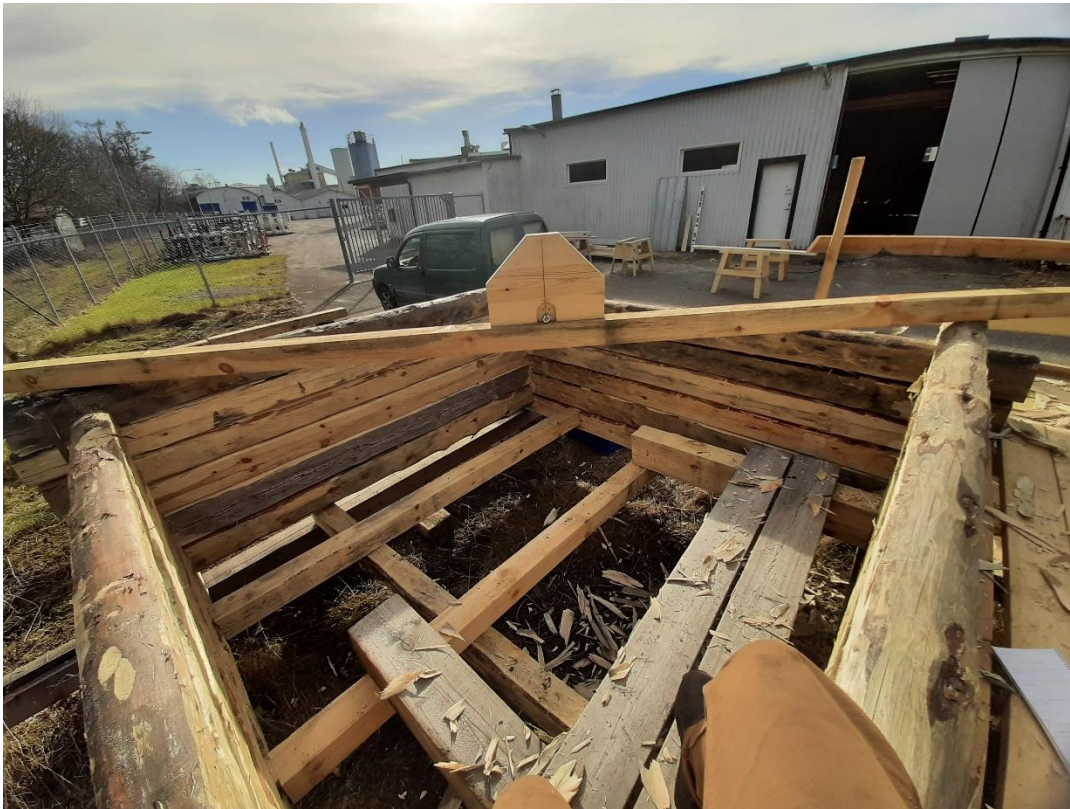
Figur 72 Vågbrädans funktion som referens för att veta skillnader mellan knuthörn.
