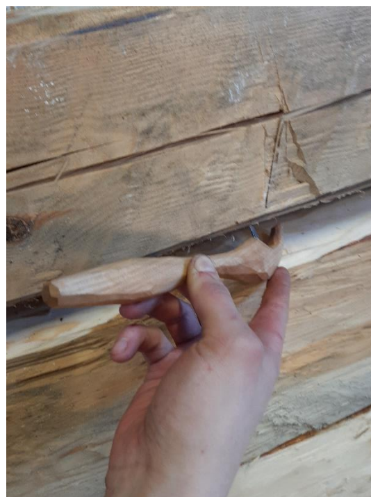
Figur 45 Den andra av dragen används (T1). Med försökt till att efterlikna som det dras på bilden. Det som inte gick med detta drag var att försöka hålla draget på samma sätt från den ena sidan till den andra. Påverkan av hur stor vankant eller inte påverkade också om det ens gick att hålla den i samma position. Även att hitta en parallell punkt på anhållet och ritsen var svår att se och skiftade även beroende på hur nära understocken låg den övre. Kanske ska detta drag fungera som ett beskrivs i Timmerbyggnader (Andersson, 2016, ss. 220) Eller så blev något fel vid tillverkningen.
