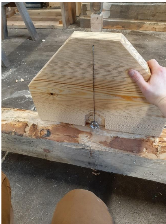
Figur 9 Här visar bilden då vågen på de undre syllstockarna togs. På grund av att golvet inne i bygghallen var relativt jämnt så fanns inget att jämna ut direkt, det var bara att börja timra. Kan vara så att om underlaget skulle ha varit mer ojämnt skulle detta ha påverkats mer.
