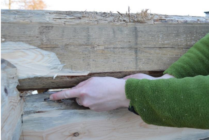
Figur 41 Här dras stocken med (T2) och det bestämda avståndet mellan klorna. Draget fick lite för långa klor som vid högt tryck på kunde skänklarna böja ihop sig lite vilket gjorde att draget inte slöt tätt på vissa ställen.
