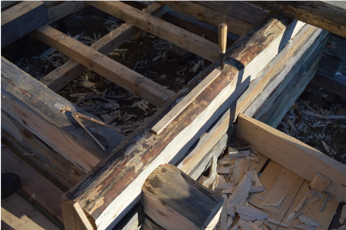
Figur 77 Verktygens tänkta funktion har brutits ner under arbetet då de även kunnat följa med i andra moment. Även olika kombinationer av verktygen har lett till mer funktioner hos verktygen. Även fast de fungerar för avsatta momenten så finns det möjlighet att flytta emellan. Fler möjligheter än som visats i detta arbete. Bilden visar passare, kniv, måttstock. Dessa verktyg fungerade som komplement till varandra vid flera tillfällen. Foto Elin Grahn
