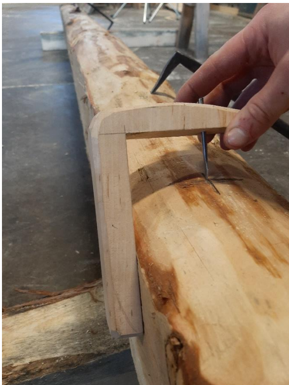
Figur 36 Timmer - riet används för att markera ut centrum på knut i undersyllarna.
