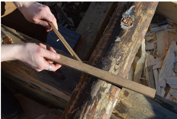
Figur 73 Passare används för att markera tröskel med måttstock som guide för att följa toppen på rundningen av stocken. Foto Elin Grahn.
