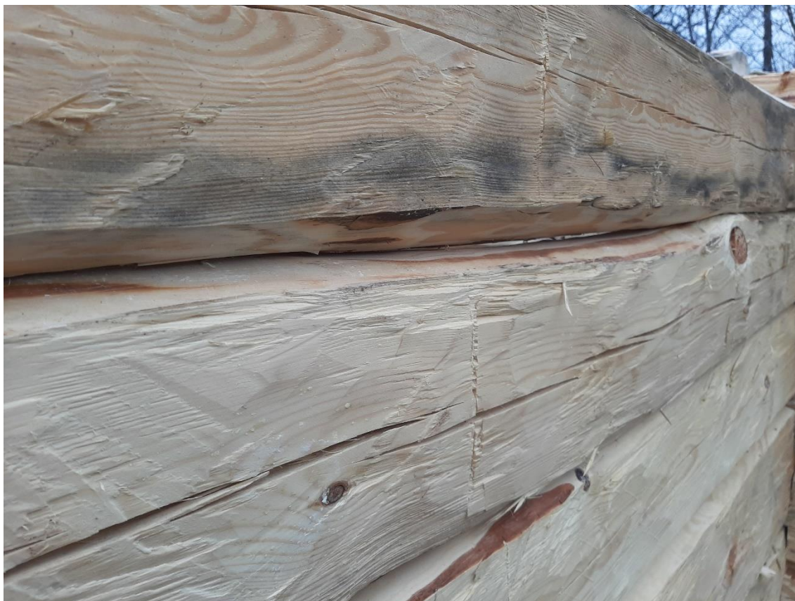
Figur 48 Två resultat av drag med yxan där det tillverkade draget inte gick att använda. Fig. 47 visar där överstocken landat precis där den parallella ritsen i understocken är. I denna bild visas ett drag som inte riktigt blev så och visar på att s – böjen varit så pass markant att en del inte omsluter den undre stocken. Detta berodde även på att stocken under hade en liknande s – böj men följde inte riktigt den övre utan lite åt motsatta hållet.
