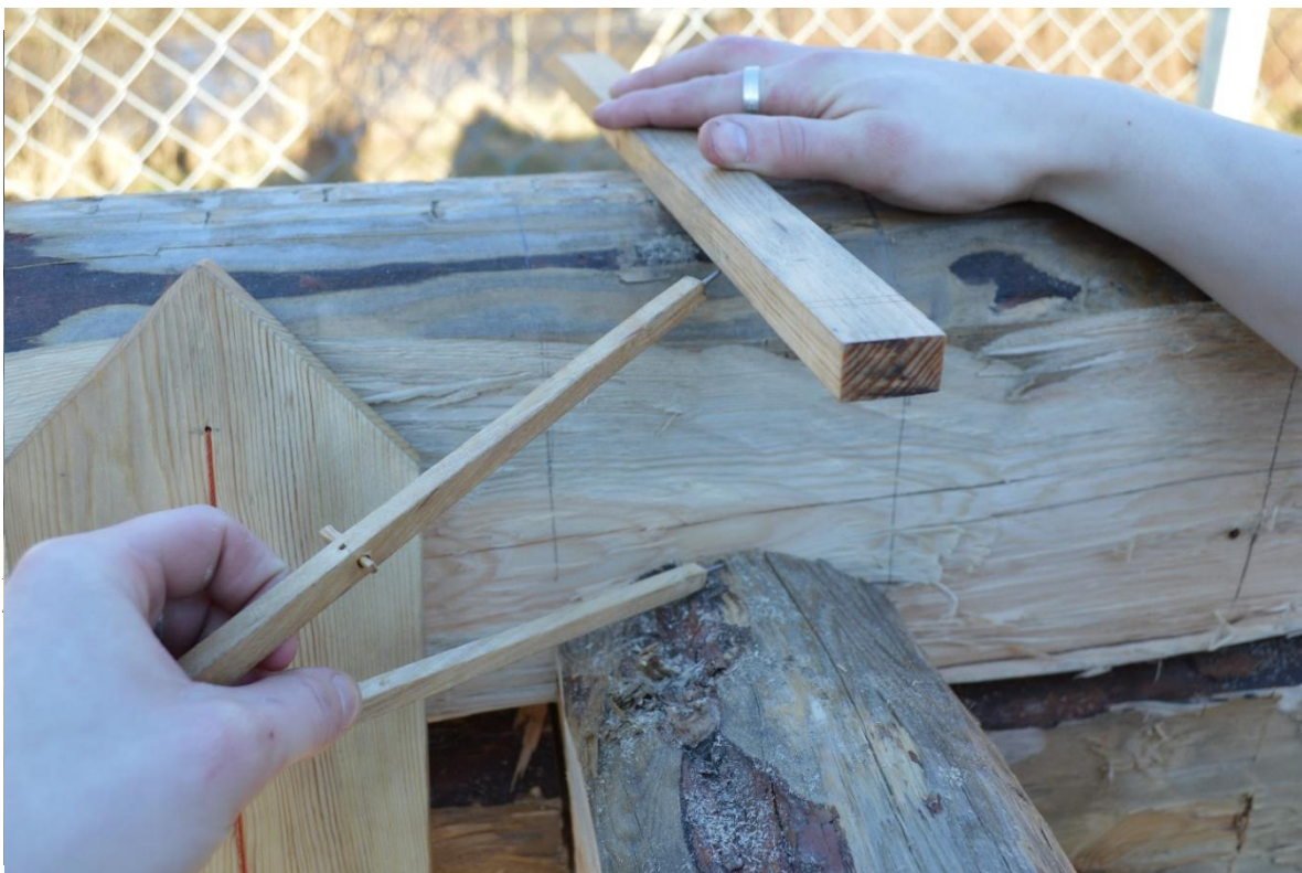
Figur 22 Uppsticket i överhaket tas ut med passare och måttstock. Måttstocken fluktas i våg. Foto Elin Grahn
