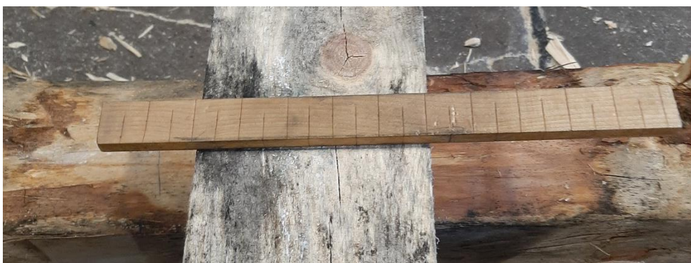
Figur 31 Måttstockens bredd används för att markera längden på laxstjärten.
