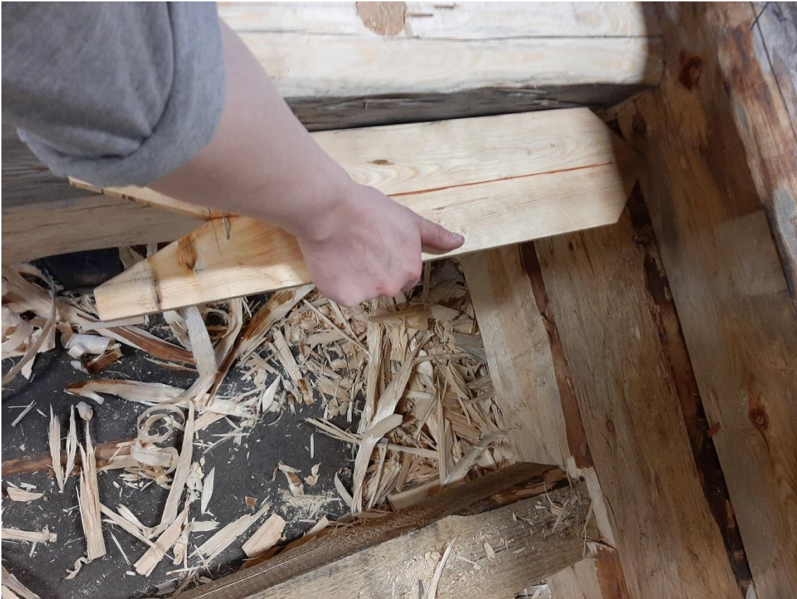
Figur 18 Lodbrädans höjd användes för att markera ut för dörr - fönsteröppningar. Samma mått användes för att placera ut golvbjälkarna. Men då gjordes det inte med lodbrädan.
