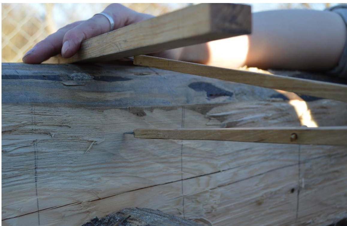
Figur 24 Halva uppsticket markeras ut. Detta blir djupet på överhaket. Foto Elin Grahn
