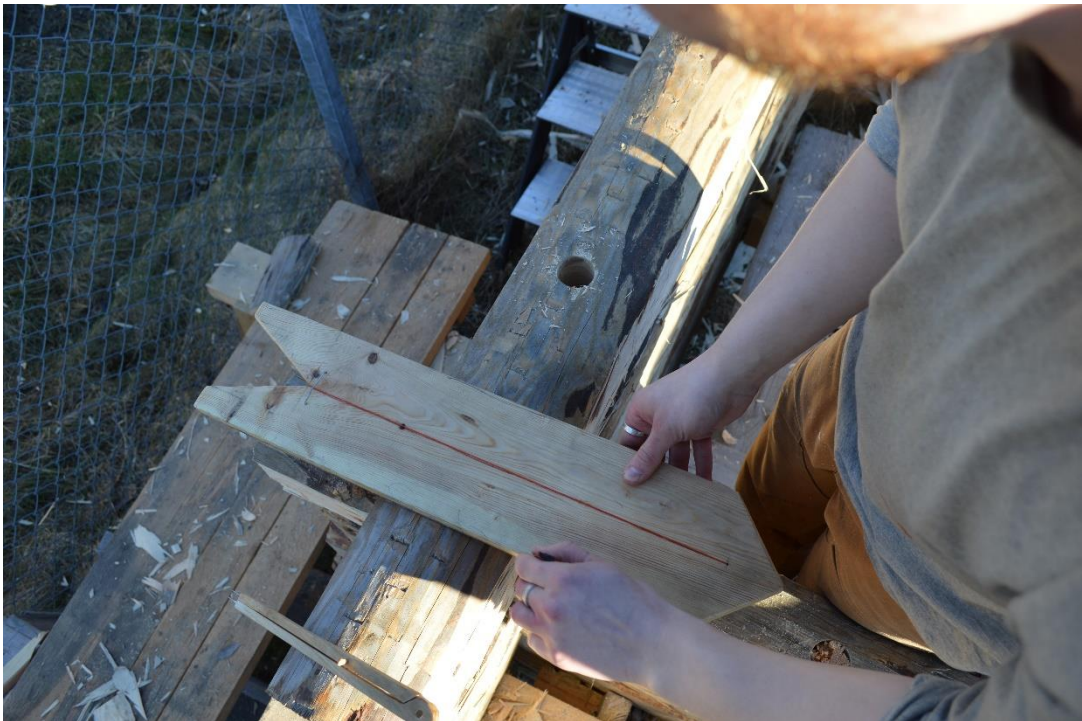
Figur 15 Här används lodbrädan för att markera på ett överhak. Lodbrädan placerades konsekvent mot nedre stocks insida på insida hörn och utsida hörn. Sedan användes bredden av lodbrädan för att markera ut nästa sida av haket. Då stockarna inte var jämntjocka gjordes detta för att alltid få samma bredd på överhaket. Ojämnheter hamnar på utsidan av väggen. Foton Elin Grahn
