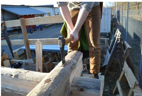
Figur 50 Knutyxan används för att hugga ur för tröskeln i ett överhak. Foto Elin Grahn
