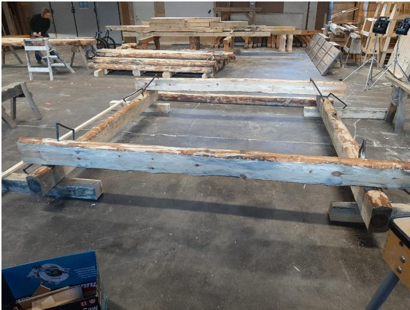
Figur 49 Syllvarvet fasthakat i pallningen. Mått ska tas för att vet hur mycket översyllarna ska ner i undersyllarna.
