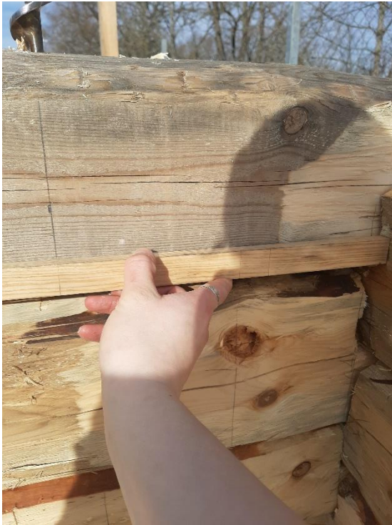
Figur 66 Placering av dymlingar. Markeringarna på måttstocken anpassat efter vars dymlingar behövs i konstruktionen.
