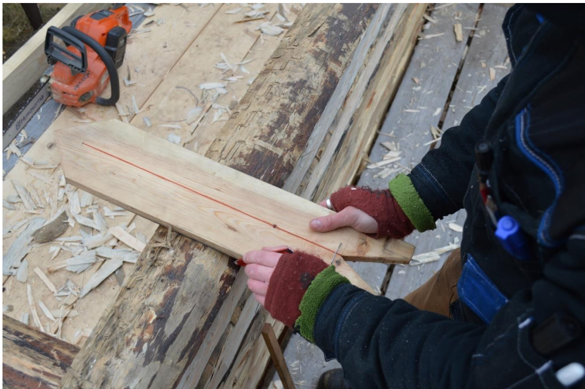
Figur 16 Lodbrädan placerades platt på toppen av rundningen och kanten av lodbrädan fluktas in mot strecket. Här används en snickarpenna som är kluven på mitten och får då en helt rak kant gör det lätt att följa med lodbrädans sida upp på rundningen. Foto Elin Grahn
