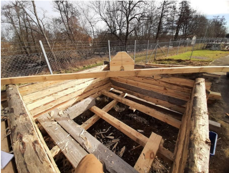
Figur 68 Med en grövre bräda passade utformningen bättre med användandet.
