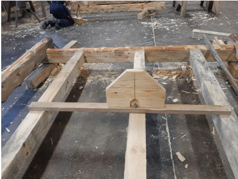
Figur 10 Visar att använda en planka eller läkt som hjälpmedel för att kunna välja mellan vilka punkter vågen kollas. Här kollas vågen mellan golvbjälkarna och här behövde de yttre bjälkarna sänkas ner för att hamna där den mittre är. Avståndet mellan undersidan på plankan gav mig avståndet för att kunna sänka ner bjälkarna till samma nivå. Så avståndet överfördes till båda sidorna av de yttre golvbjälkarna.
