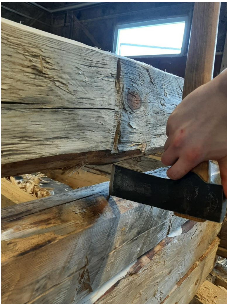
Figur 46 Knutyxa används för att dra en stock som har en s - böj. Då måste stocken placeras högt för att kunna dra över hela stocken.
