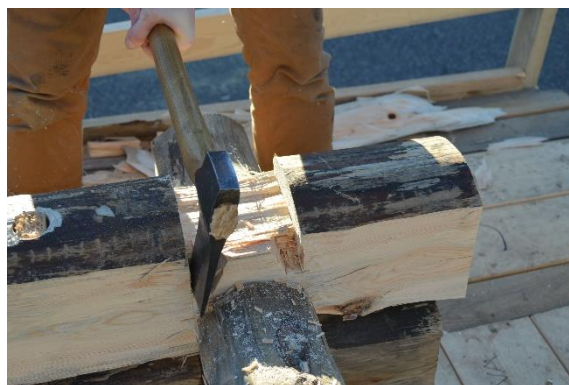
Figur 51 Inhaket i överhaket huggs ut. Foto Elin Grahn
