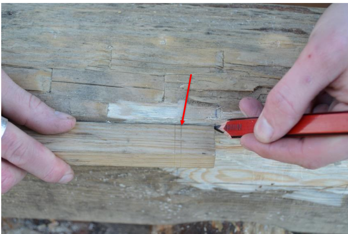
Figur 28 Efter en markering på måttstocken dras den inre sidan av underhaket in för att placeras inne i inhaket. Foto Elin Grahn
