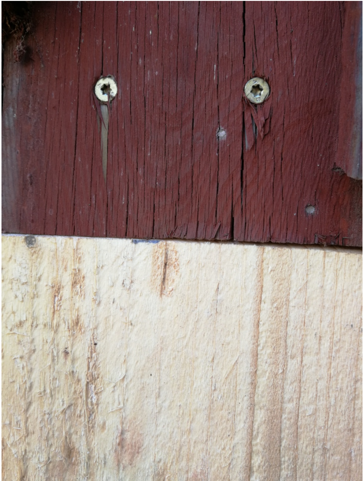
Figur 21. Egen metod. Den nya biten testas. Viss glipa syns, som sedan justeras genom att mer material tas bort på den vänstra sidan, men hjälp av en cirkelsåg. Tillfälliga skruvar håller den övre biten på plats.
