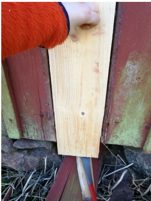
Figur 7, Metod 1. Kofot används för att pressa ihop skarven
