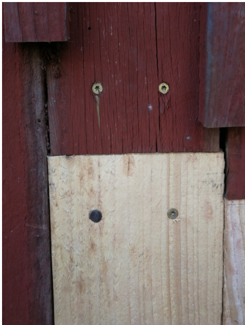
Figur 24. Egen metod. En i taget byts skruvarna ut till spik.
