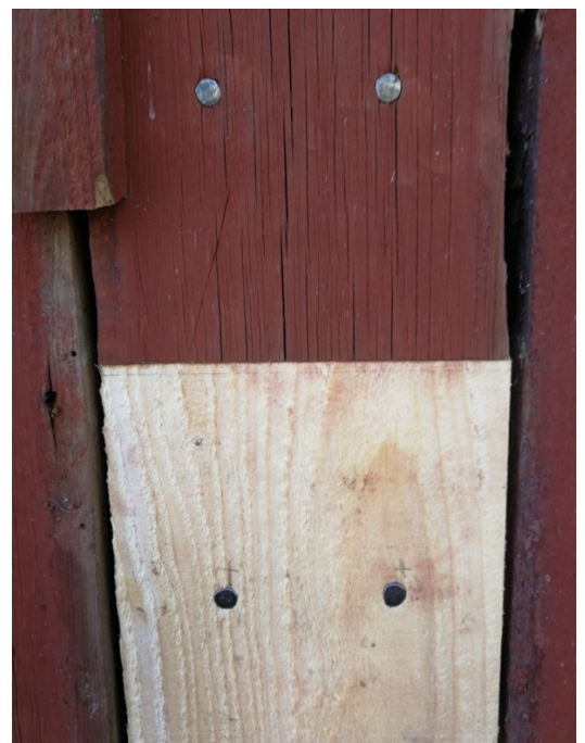
Figur 8. Metod 1, spikarnas placering
