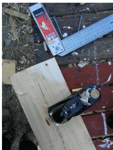
Figur 20. Egen metod. Hyvel används för att dimensionera den nya biten, för att få en jämn skarv.
