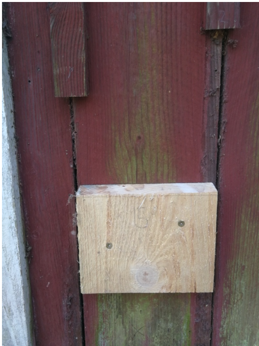
Figur 9. Metod 2. Kloss sågad i 15° som stöd
