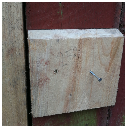
Figur 19. Egen metod. 25° kloss används för att såga av panelbräda
