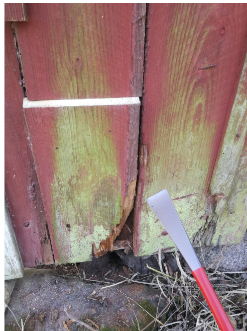
Figur 10. Metod 2, koben används för att ta bort den bit som ska ersättas
