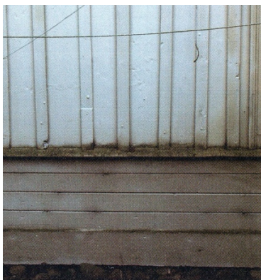
Figur 1. Nedersta delen av panelen är utbytt mot liggande panel. Foto ur Handhyvlad panel i Hjo (Almevik & Renström, 2004)
