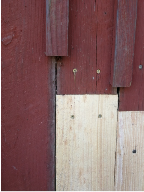
Figur 22. Egen metod. Tillfälliga skruvar.
