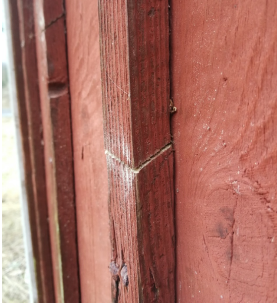
Figur 15. Metod 4, skarvsnitt sågat på fri hand
