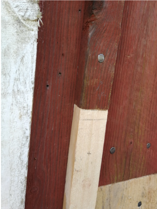
Figur 11. Metod 2, läkt skarvad med 15° skarvsnitt
